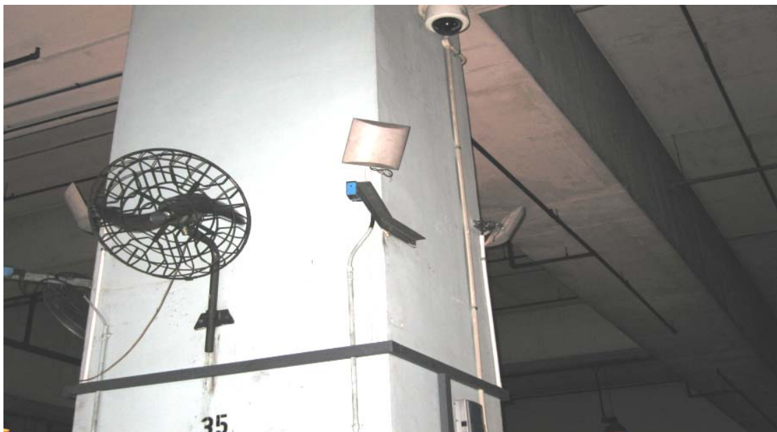
圖 3.10 主動式的 Reader 外型與安裝位置
