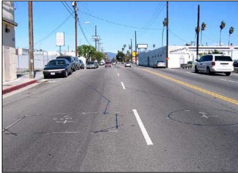
圖 2.4 環路線圈式車輛偵測器
