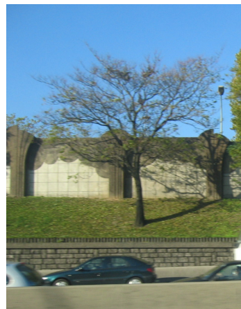
道路路塹段時，搭配土坡植栽遮蔽隔音牆牆腳，並柔化減低隔音牆高度及壓迫感。
