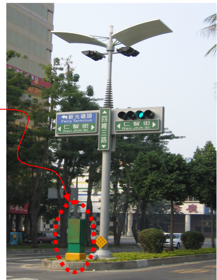
圖 6.5-1 公路標誌、號誌及照明共構式設計案例 (照片來源：楊東霖攝，2004)
