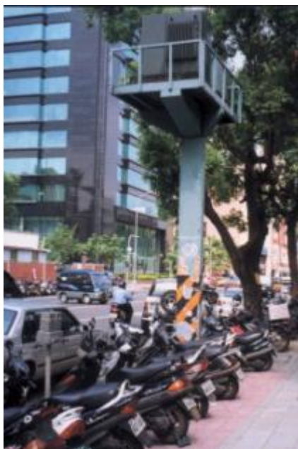
圖 6.8-2 輸配電設施採立體方式配置之案例
