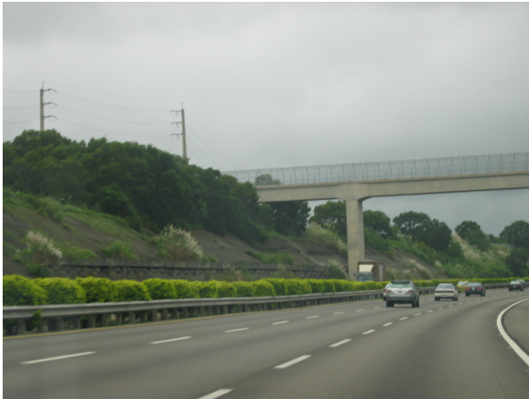
圖 6.9-6 中央分隔島(帶)護欄採植栽防眩之景觀效果
