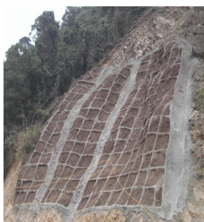
採可植生之型框工法，噴植速生性草種及當地現有蔓藤物種
