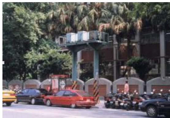
圖 6.8-2 輸配電設施採立體方式配置之案例
