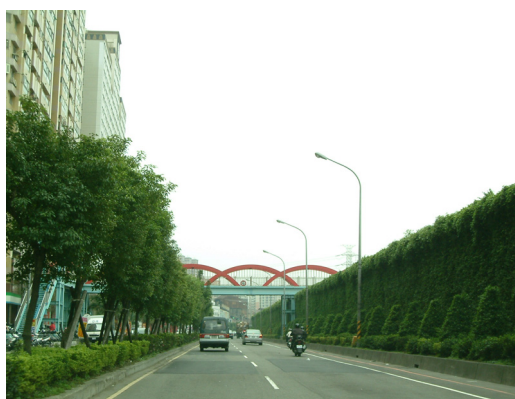
公路緊鄰路側之擋土牆，留設植栽帶，可供綠化並減輕擋土牆設施對景觀之負面影響。
