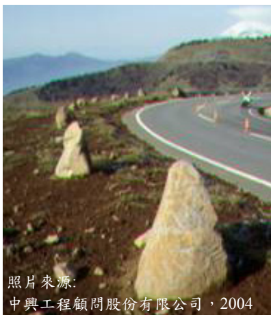
圖 6.9-5 路側護欄配合環境及景觀之造型及設置手法
