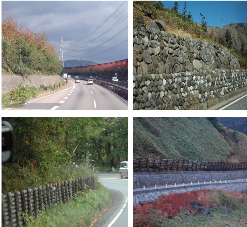
圖 6.3-1 以擋土牆使邊坡擾動最小之案例照片
