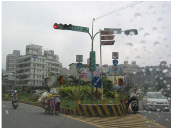
「減法」：(本照片為不佳案例) 整合改善路口公路構造物及附屬設施物，如標誌、防撞護欄，以簡化道路設施，避免「重點景觀區」景觀雜亂，以凸顯「重點景觀區」之植栽特色主題
