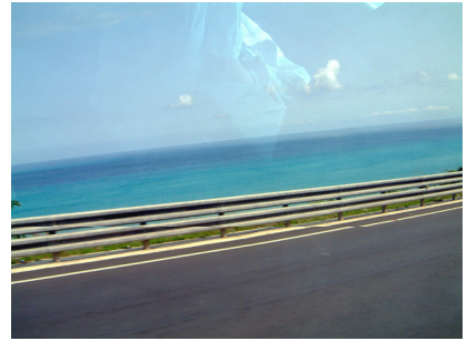
採用具視野穿透性的護欄，但視 野穿透性有限，可再考慮其它具 視野穿透性的護欄型式
