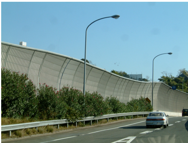
隔音牆路側留設植栽空間，供植栽遮蔽隔音牆牆腳，並柔化減低隔音牆高度及壓迫感。
