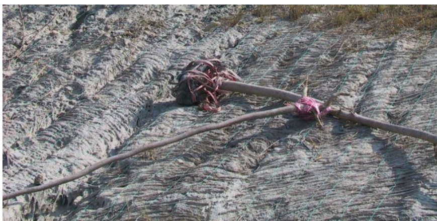
圖 7.3-13 植栽土球包裹不良造成植栽根部裸露
