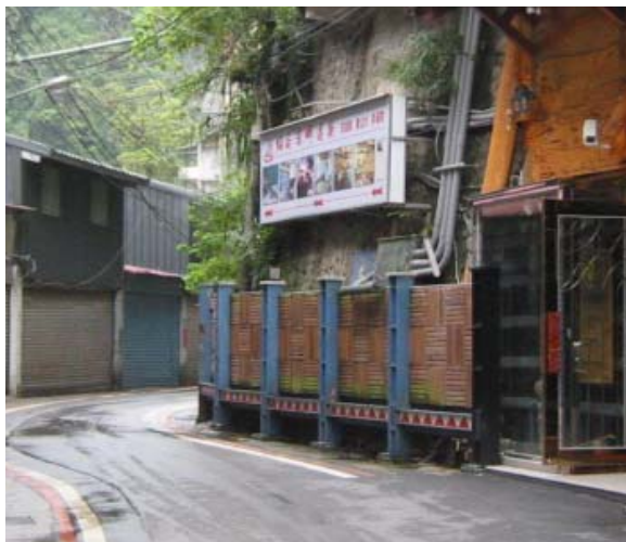
圖 4.4-6 以景觀牆遮蔽公路沿線水電管線之手法
