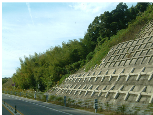
圖 6.3-4 不可植生護坡與可植生護坡之景觀比較
