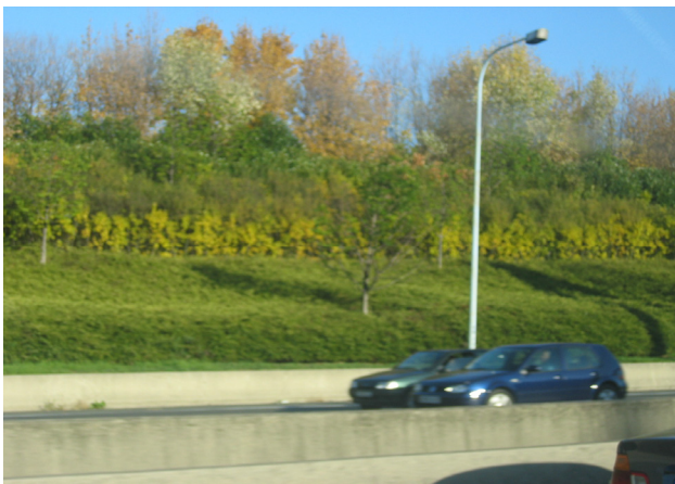
道路路塹段時，搭配土坡植栽遮蔽隔音牆牆腳，並柔化減低隔音牆高度及壓迫感。
