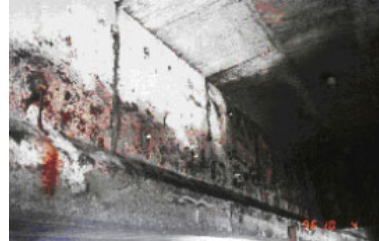
圖 2-2 腐蝕、龜裂與破裂之連續循環現象例
