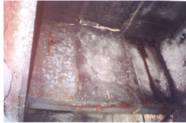
圖 2-2 腐蝕、龜裂與破裂之連續循環現象例
