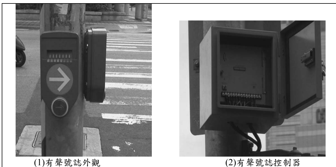
圖 3.3.26 北市有聲號誌外觀及其控制器
