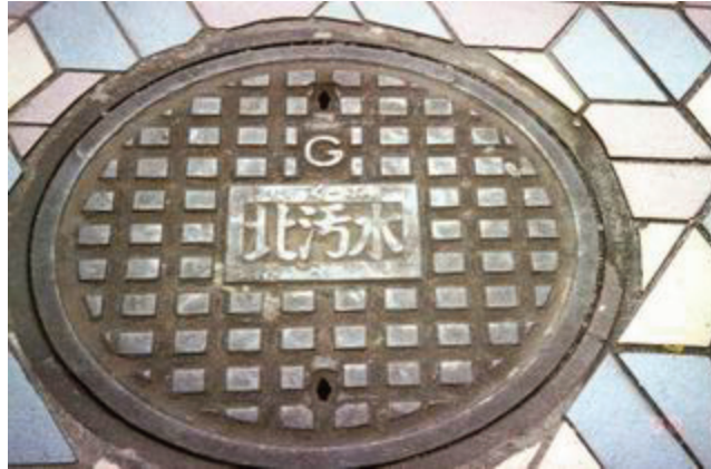
圖附錄 1.42 衛生下水道工程處圓形手孔蓋(直徑 600mm、750mm、1000mm)
