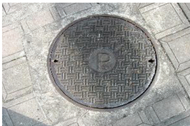
圖附錄 1.41 政部警政署警察電訊所臺北分所圓形人孔蓋(直徑 768mm)
