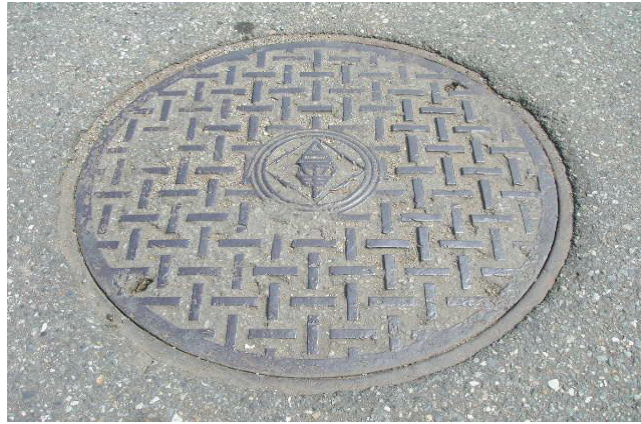
圖附錄 1.1 臺電臺北北區營業處圓形人孔蓋(直徑 740mm)
