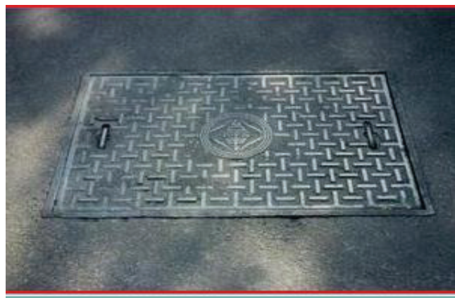
圖附錄 1.6 臺電臺北北區營業處矩形人孔蓋(780mm×750mm)
