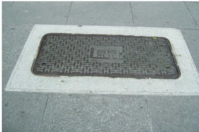
圖附錄 1.34 電信公司矩形人孔蓋(1200mm×600mm)
