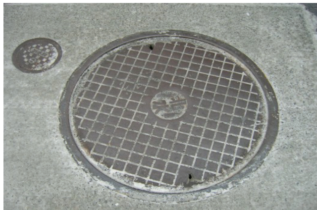
圖附錄 1.16 臺北自來水事業處北區營業分處圓型人孔蓋(直徑 800mm)
