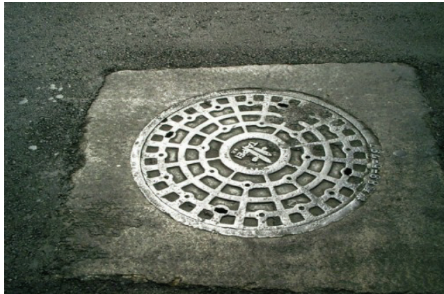
圖附錄 1.43 水利工程處圓形人孔蓋(直徑 660、900mm)
