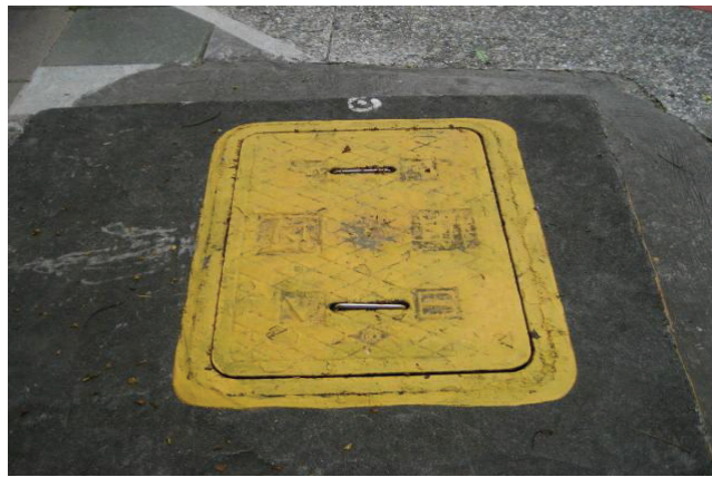
圖附錄 1.25 陽明山瓦斯公司矩形人孔蓋(880mm×680mm)
