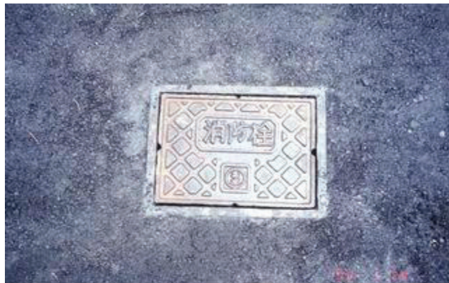
圖附錄 1.11 臺北自來水事業處南區營業分處消防栓(40mm×30mm)
