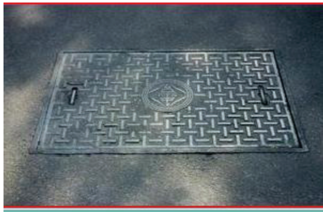
圖附錄 1.8 臺電臺北南區營業處矩形人孔蓋(1200×800mm)
