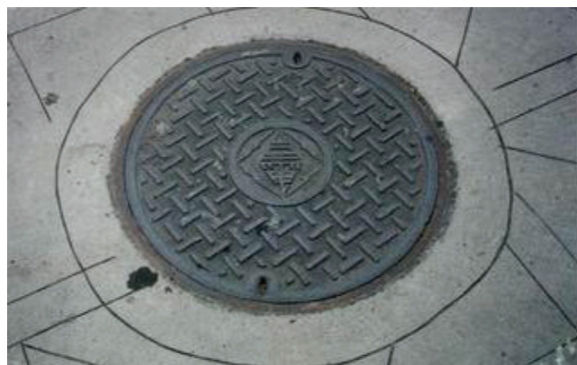
圖附錄 1.3 臺電臺北南區營業處圓形人孔蓋(直徑 780mm)
