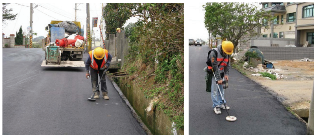
圖 3.1 利用金屬探測器進行人手孔蓋位置定位
