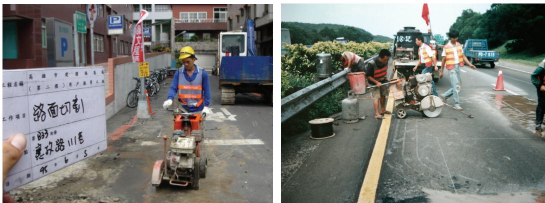
圖 3.3 路面切割作業
