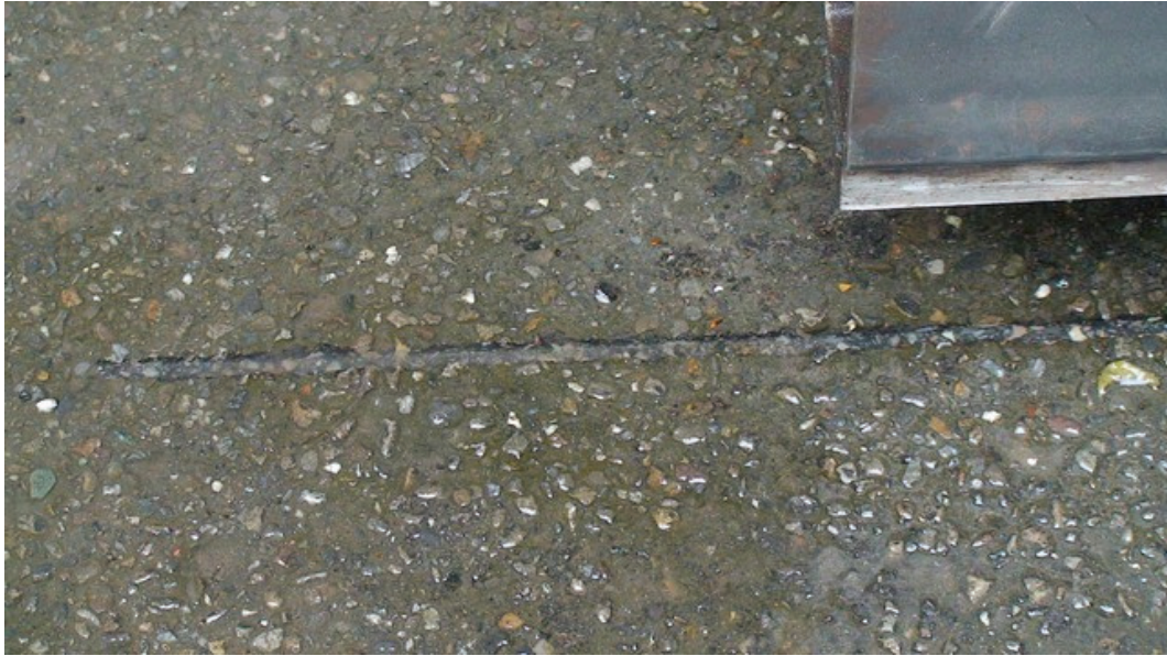
圖 4.44 鑽石鋸片實際切割後於路面留下之切割痕
