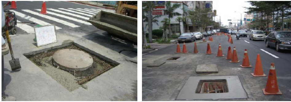
圖 3.8 澆置早強水泥混凝土
