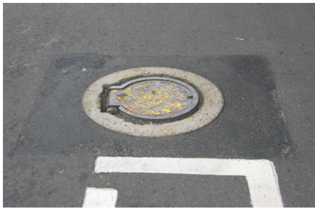
圖附錄 1.28 陽明山瓦斯公司圓形手孔(材直徑 650mm)
