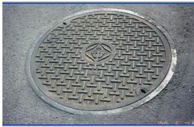
圖附錄 1.5 臺電臺北南區營業處圓形人孔蓋(1200mm)
