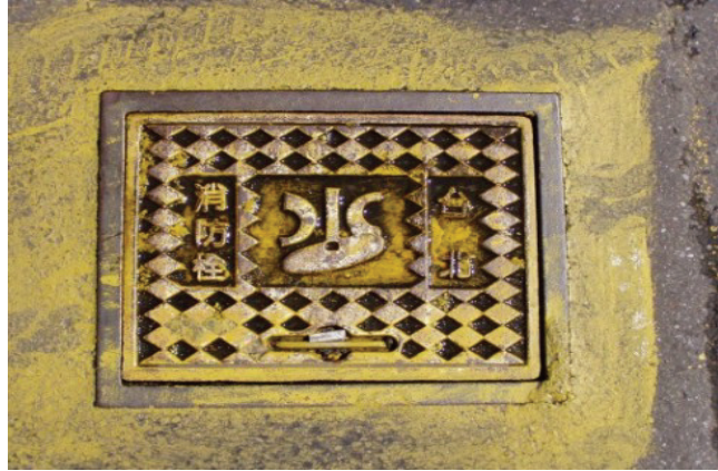
圖附錄 1.12 臺北自來水事業處北區營業分處地下式消防栓(410mm×320 mm)
