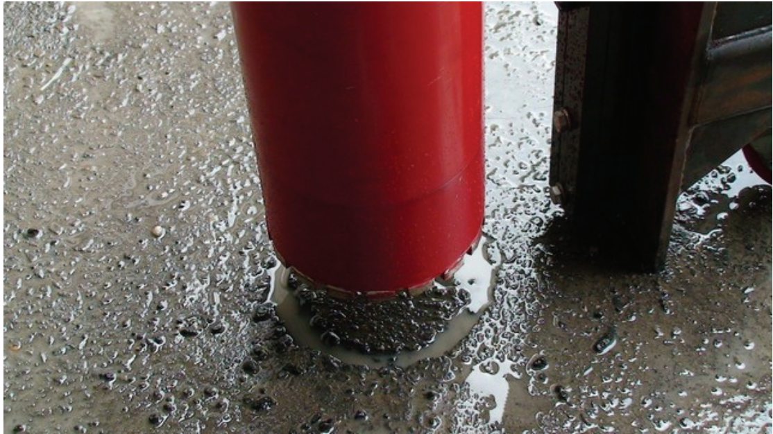
圖 4.40 鑽孔機完成鑽孔作業後於路面留下之痕跡
