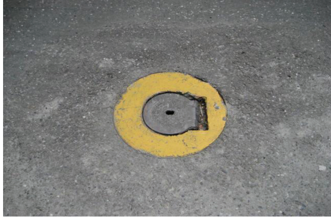
圖附錄 1.27 陽明山瓦斯公司圓形手孔蓋(直徑 340mm)
