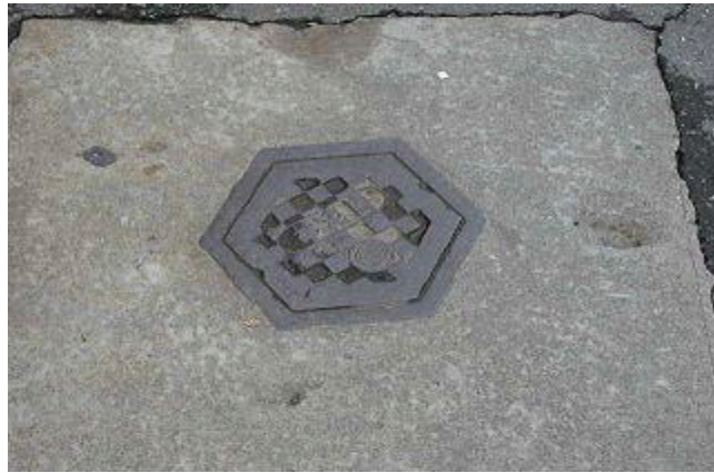
圖附錄 1.10 臺北自來水事業處陽明營業分處六角形手孔(邊長 120mm×6 邊形)
