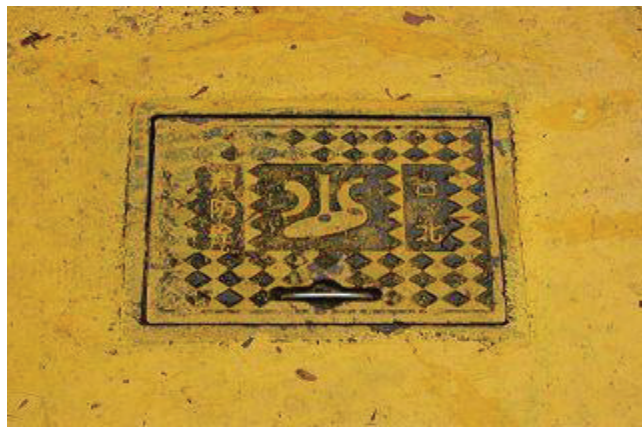
圖附錄 1.13 臺北自來水事業處陽明營業分處矩形手孔(300mm×400mm)
