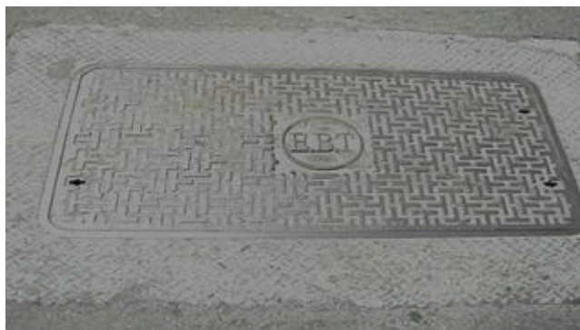
圖附錄 1.35 亞太固網寬頻公司矩形人孔蓋(1200mm×600mm)
