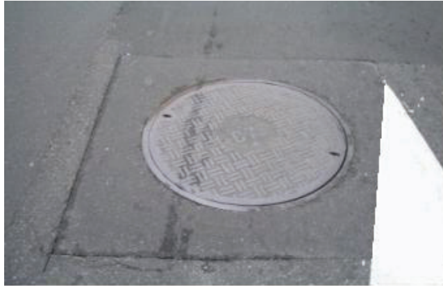
圖附錄 1.33 冠有線電視公司圓形人孔蓋(直徑 750mm)
