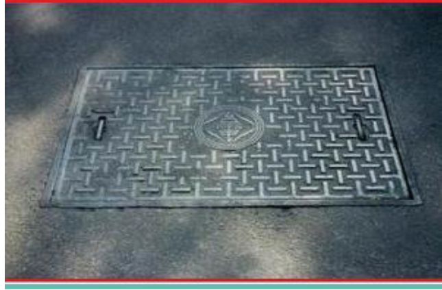
圖附錄 1.7 臺電臺北北區營業處矩形人孔蓋(1110mm×710mm)
