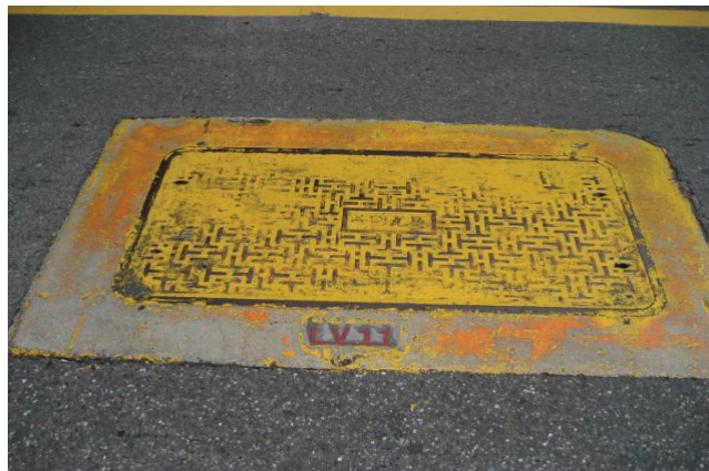
圖附錄 1.26 陽明山瓦斯公司矩形人孔蓋(1000mm×1600mm)
