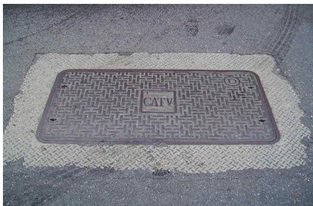
圖附錄 1.30 新台北有線電視公司矩形人孔蓋(1200mm×600mm)
