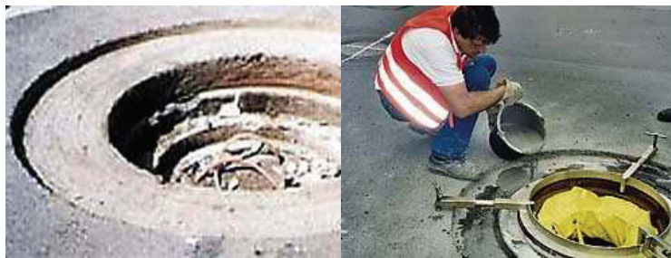
圖 2.11 調整高程差並澆置填充材料
