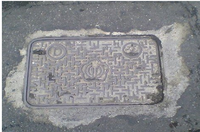
圖附錄 1.37 北市交通管制工程處矩形人孔蓋(650mm×400mm)
