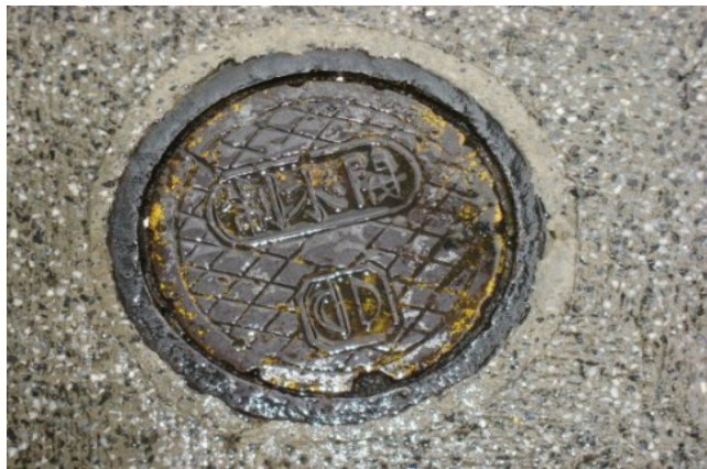
圖附錄 1.14 臺北自來水事業處北區營業分處圓型制水閥(直徑 200mm)
