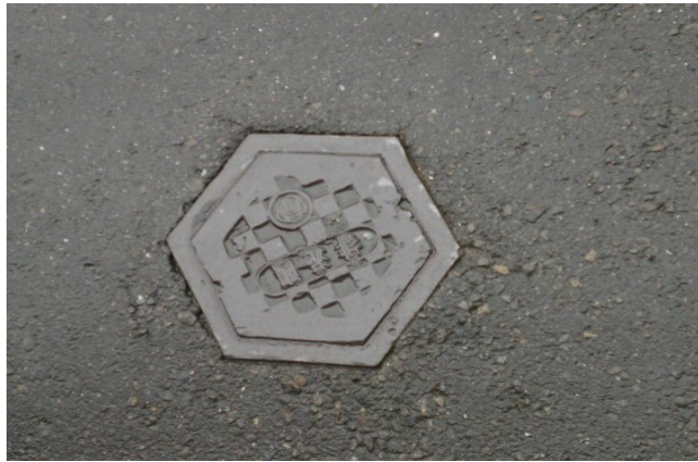
圖附錄 1.9 臺北自來水事業處北區營業分處排泥閥(140mm×6 邊形)
