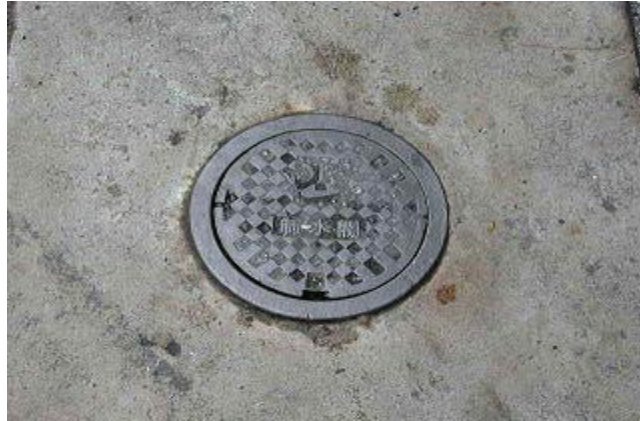
圖附錄 1.15 臺北自來水事業處陽明營業分處圓形手孔(直徑 250mm)
