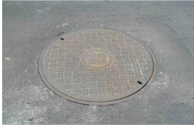
圖附錄 1.36 太固網寬頻公司圓形人孔蓋(直徑 700mm)
