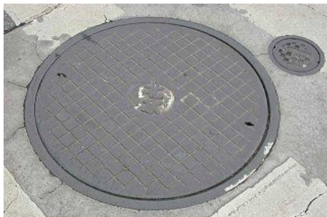
圖附錄 1.17 臺北自來水事業處陽明營業分處圓形人孔蓋(直徑 650mm~950mm)
