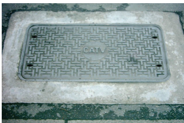
圖附錄 1.32 安文山有線電視公司矩形人孔蓋(1160mm×660mm)
