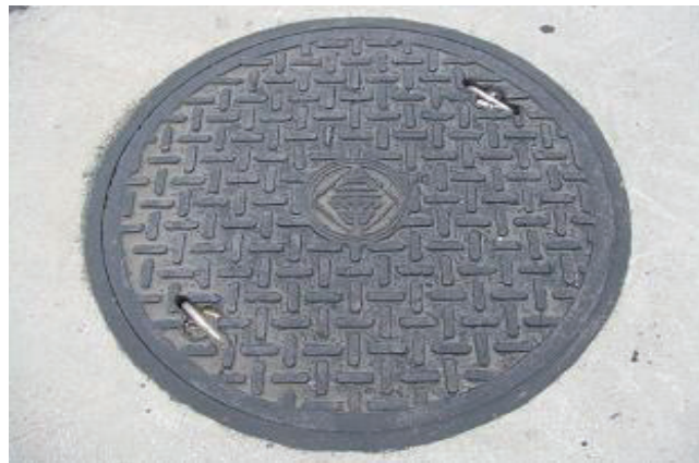
圖附錄 1.2 臺電輸變電工程處北區施工處圓形人孔蓋(直徑 750mm)
