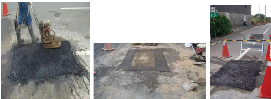
圖 3.7 利用夯實機夯實路面
