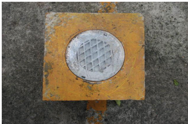
圖附錄 1.29 陽明山瓦斯公司方形手孔(350mm×350mm)
