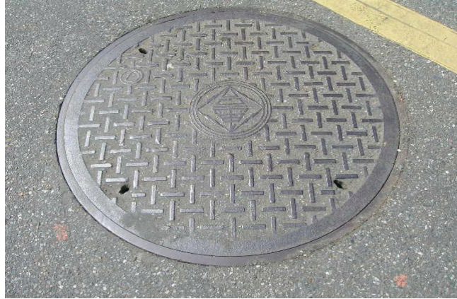
圖附錄 1.4 臺電臺北北區營業處圓形人孔蓋(直徑 1020mm)
