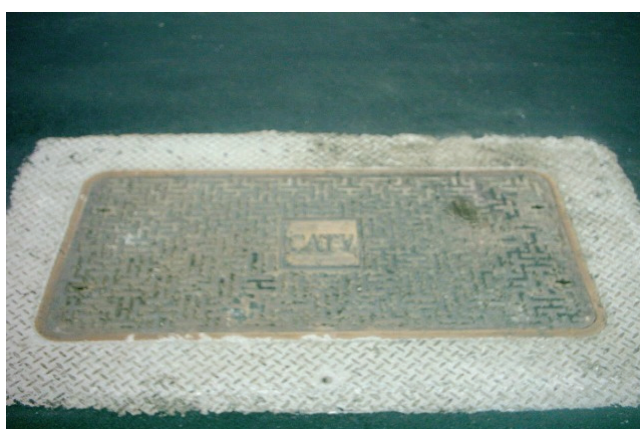
圖附錄 1.31 安文山有線電視公司矩形人孔蓋(1400mm×800mm)
