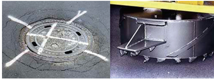
圖 2.10 將破損之人手孔蓋進行切割(費時 1-3 分鐘)
