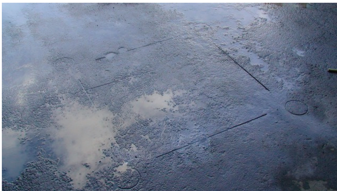
圖 4.46 小面積鋪面挖掘修補機具雛型實作測試後於路面留下之切割痕
