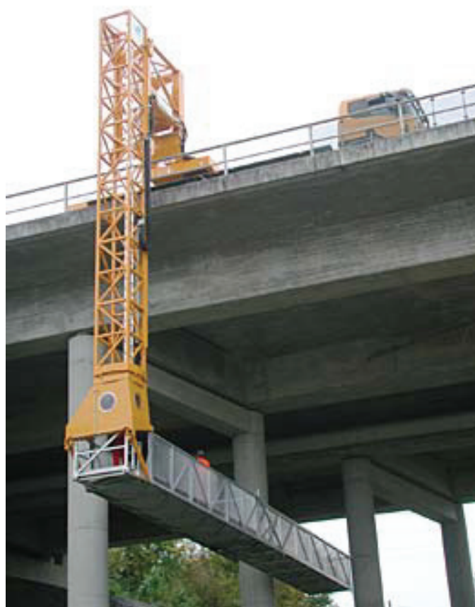
圖 2.8 MOOG 公司重型裝載設備之橋梁檢測實況之 2 [6]
