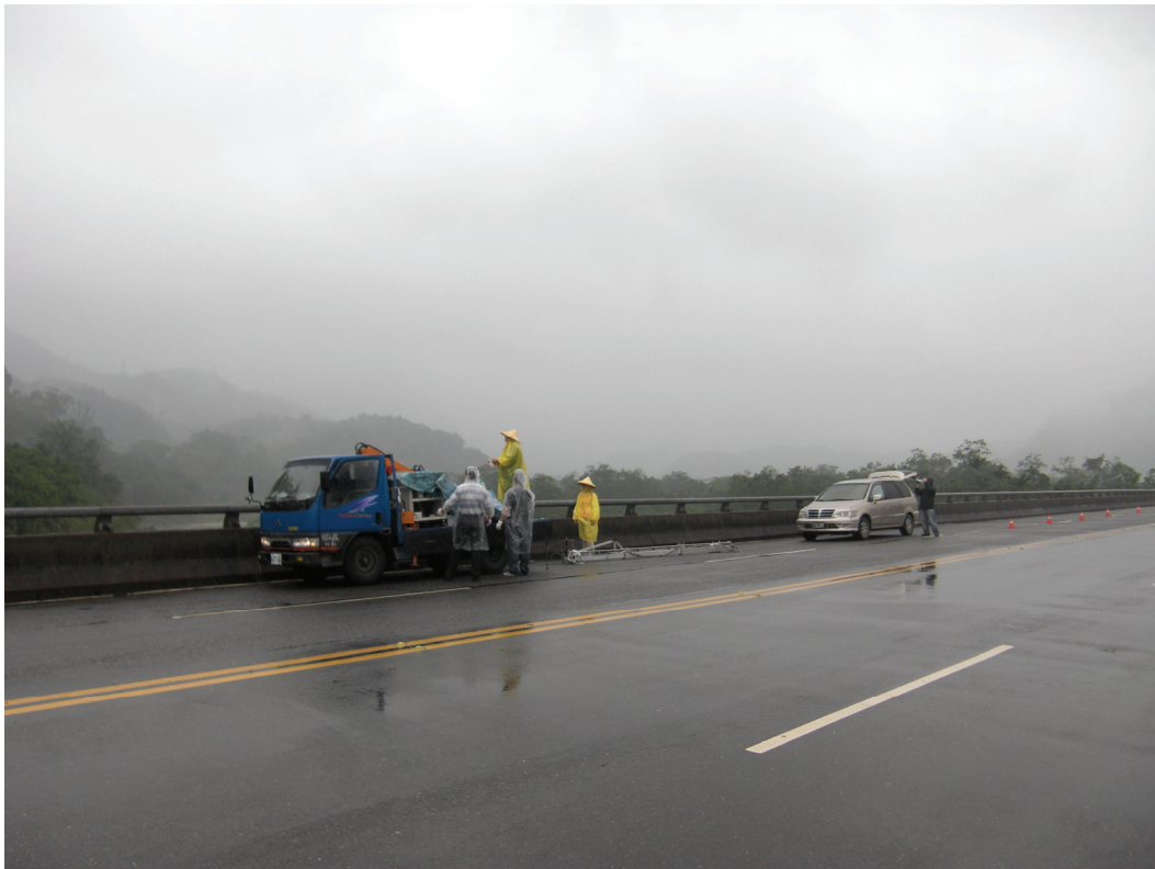
圖 4.15 橋檢車設置安全警示及機械手臂整備
