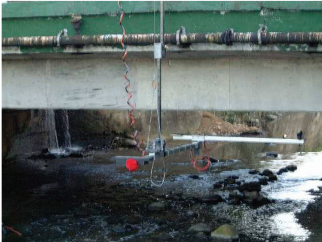
圖 2.17 橋檢車在富練橋作業實況
