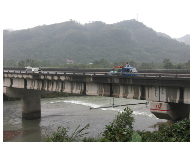
圖 4.19 橋檢車以低速向前行駛之動態檢測
