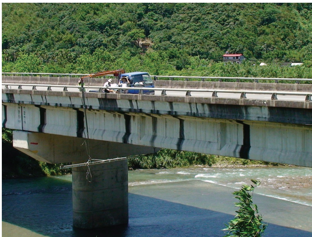
圖 4.6 機械手臂負載攝影機伸入橋面下
