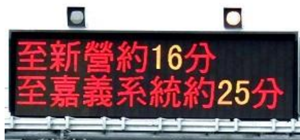
圖 3-3 資訊可變標誌(CMS)
