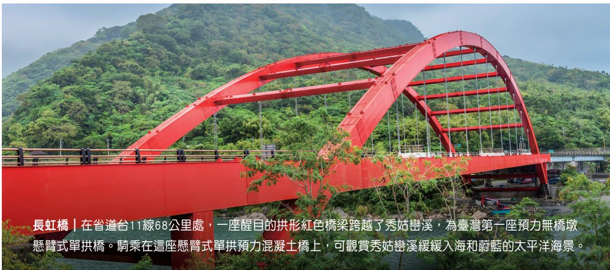
**長虹橋** | 在省道台11線68公里處，一座醒目的拱形紅色橋梁跨越了秀姑巒溪，為臺灣第一座預力無橋墩懸臂式單拱橋。騎乘在這座懸臂式單拱預力混凝土橋上，可觀賞秀姑巒溪緩緩入海和蔚藍的太平洋海景。
