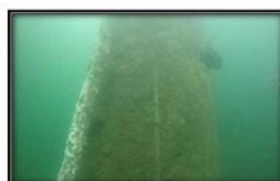
棧橋鋼管樁的陽極調查
