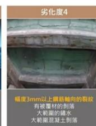
上部結構底面 (劣化度判定案例)
