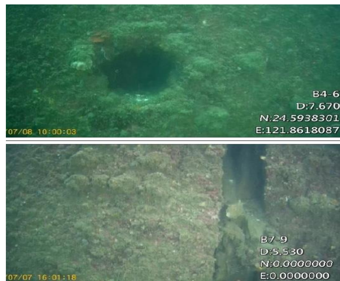
圖 4.14 碼頭壁體檢測成果 [9]
