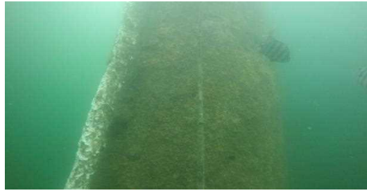
圖 4.11 棧橋鋼管樁陽極塊調查 [8]
