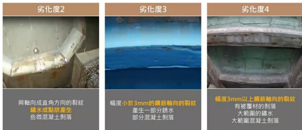
圖 3.12 上部結構底面 (劣化度判定案例)
