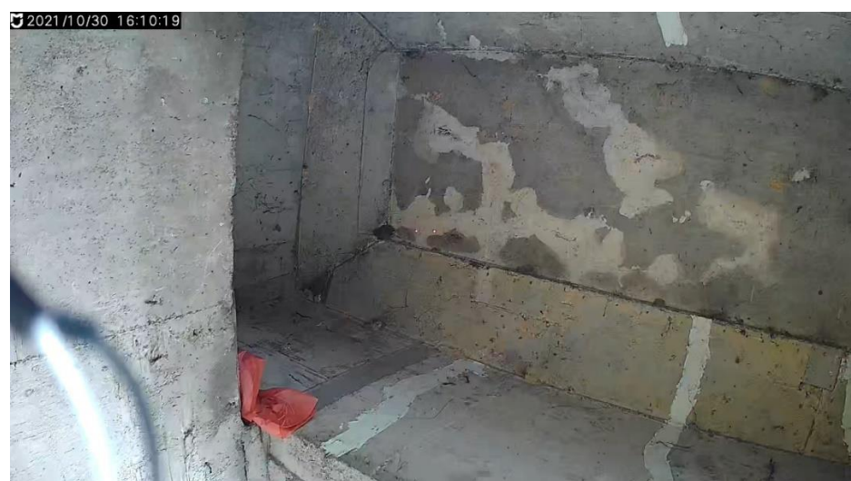
圖 10 轉動攝影裝置拍攝梁底橋台結構
