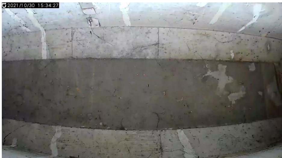
圖 9 梁底實拍影像(B)
