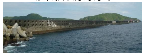
南外廓防波堤海側現況
