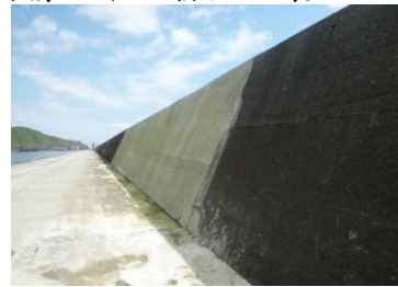
南外廓防波堤現況
