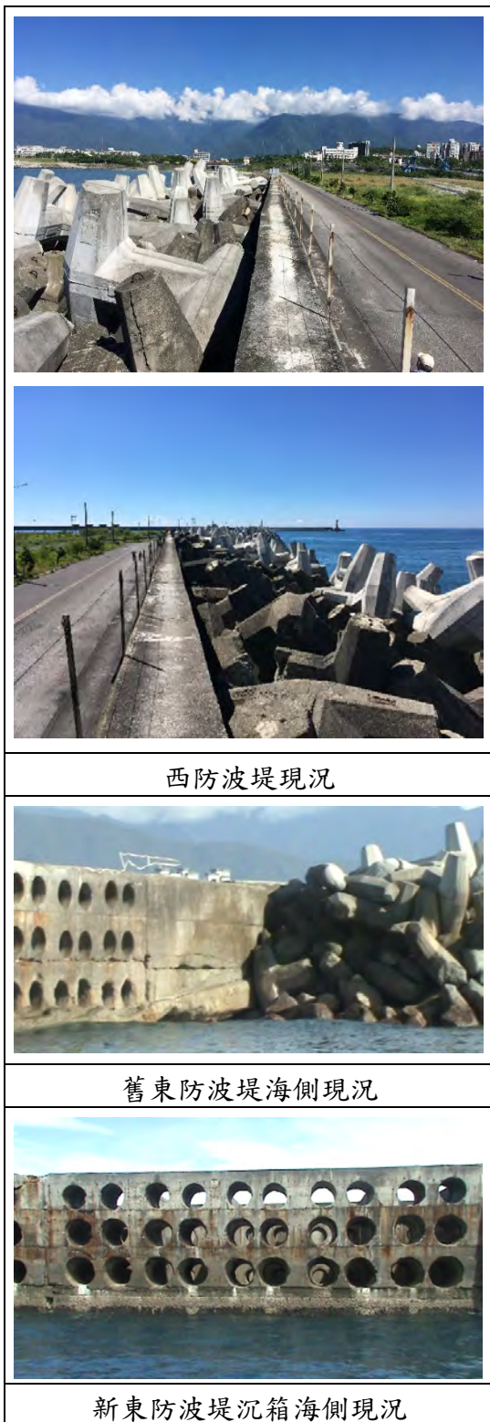
圖 5 堤體現況檢視照片
