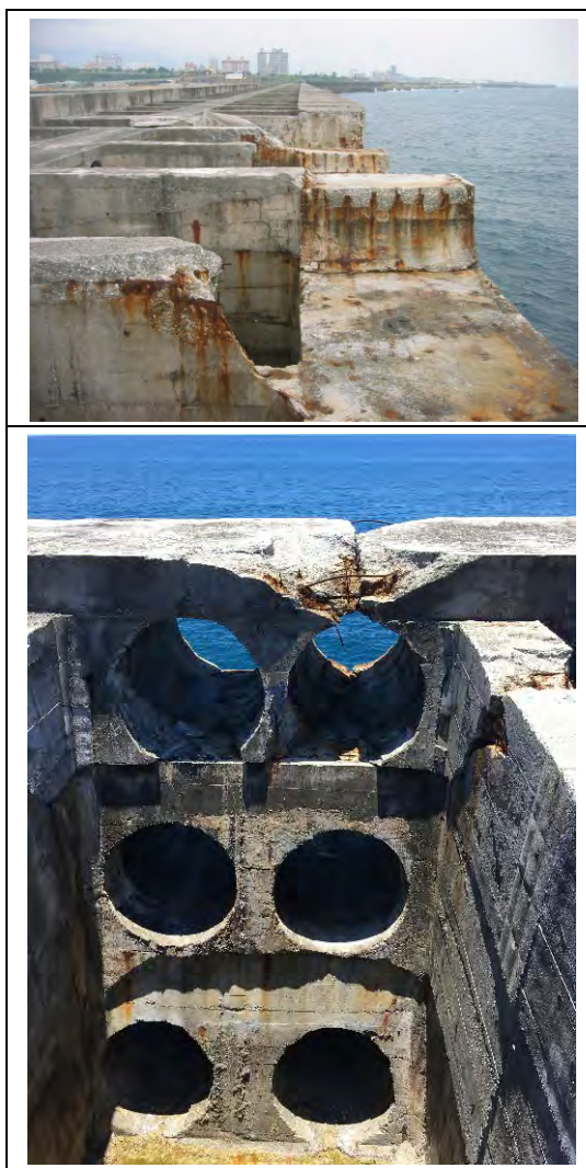
圖 10 消波艙破壞示意圖
