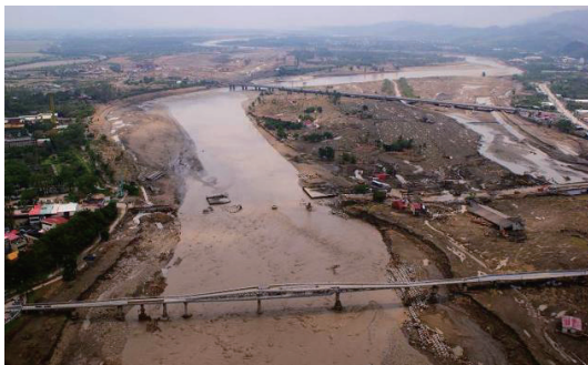
圖4 旗山地區莫拉克颱風後之受災情形，其中可見旗尾橋全毀，下游新旗尾橋左岸橋台因潰壩流衝擊而沈陷。
