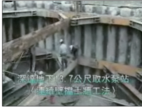
(B) 構築工法 - 連續壁施工 (摘自：台灣海洋深層水公司網站)
