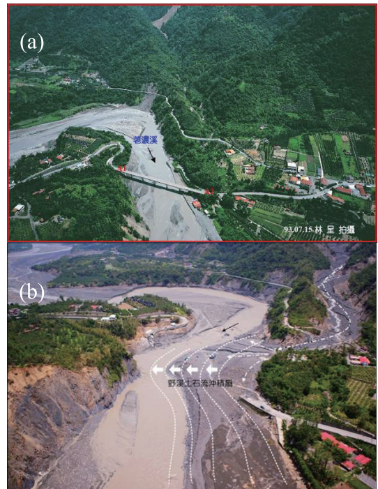
圖5 台27線新發大橋於莫拉克颱風前後之情形：(a)颱風前；(b)颱風後。
