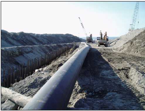
(A) 明挖回填掩埋法
