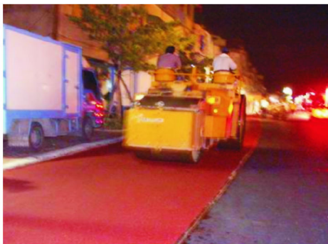
圖 13 滾壓機滾壓夯實
