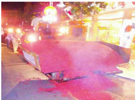
圖 12 鋪裝機鋪裝情形
