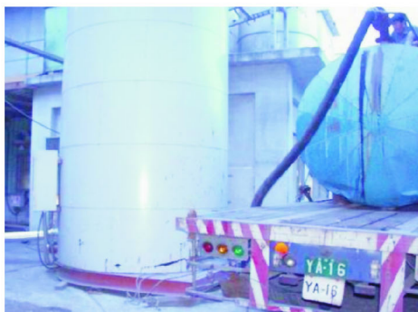
圖 7 淡黃色改質瀝青儲油槽
