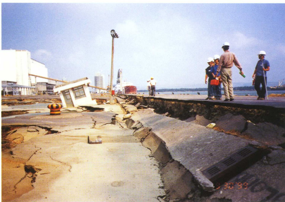
圖三 房屋傾斜及地盤龜裂
