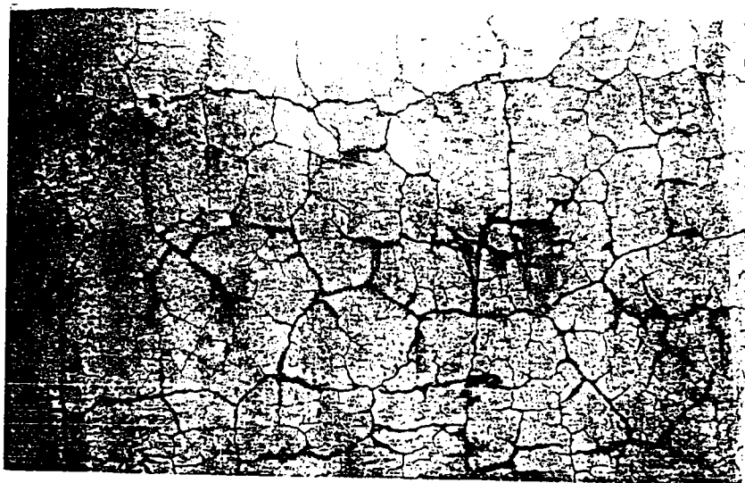
照片三 美國胡佛(Hoover)水壩齡骨材反應的案例
