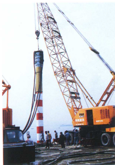
海上觀測樁運抵淡水港 正在工作平台下樁情形
