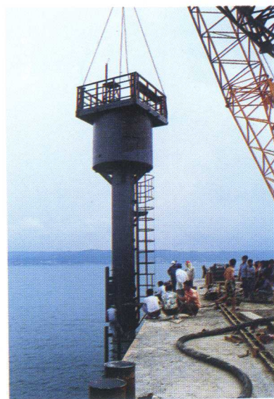
海上觀測平台完成情形
