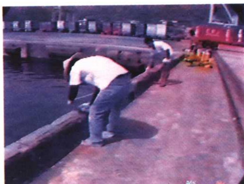
現場標示測量之鋼板樁位置
