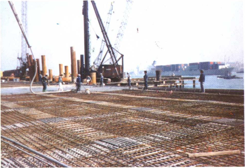
(四)碼頭面混凝土灌築。
