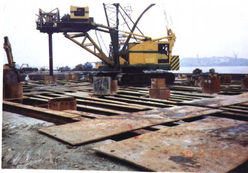
(一)鋼管樁底岩層鑽除。
