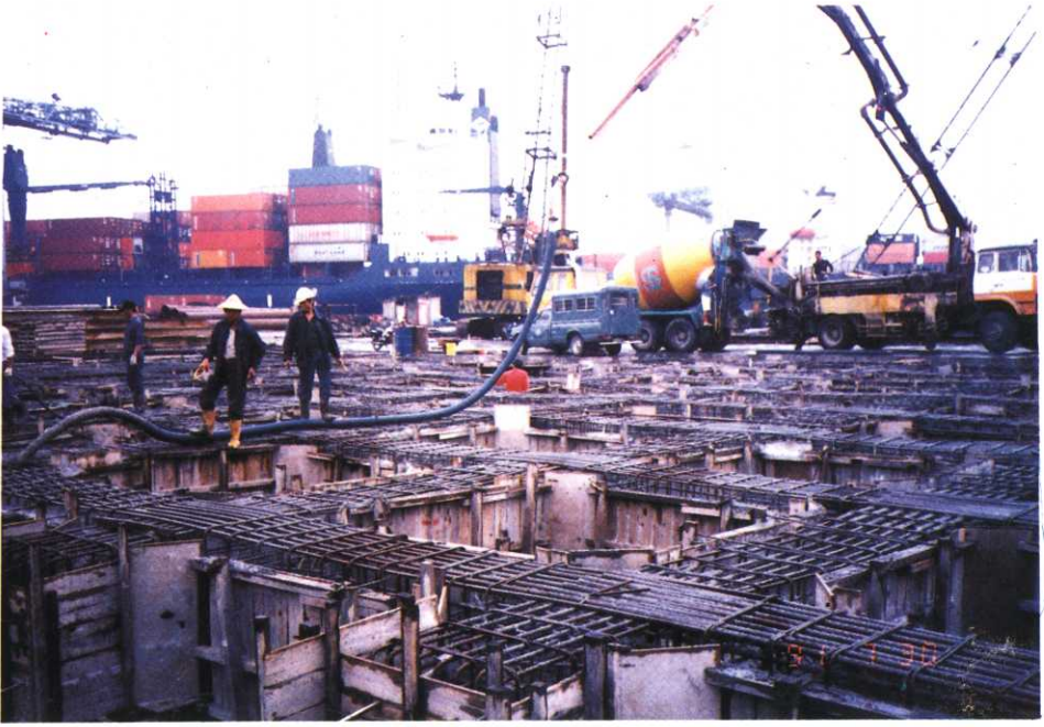
(三)碼頭大樑混凝土灌築。
