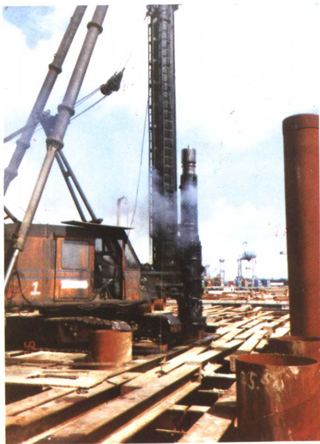
(二)鋼管基樁打設。
