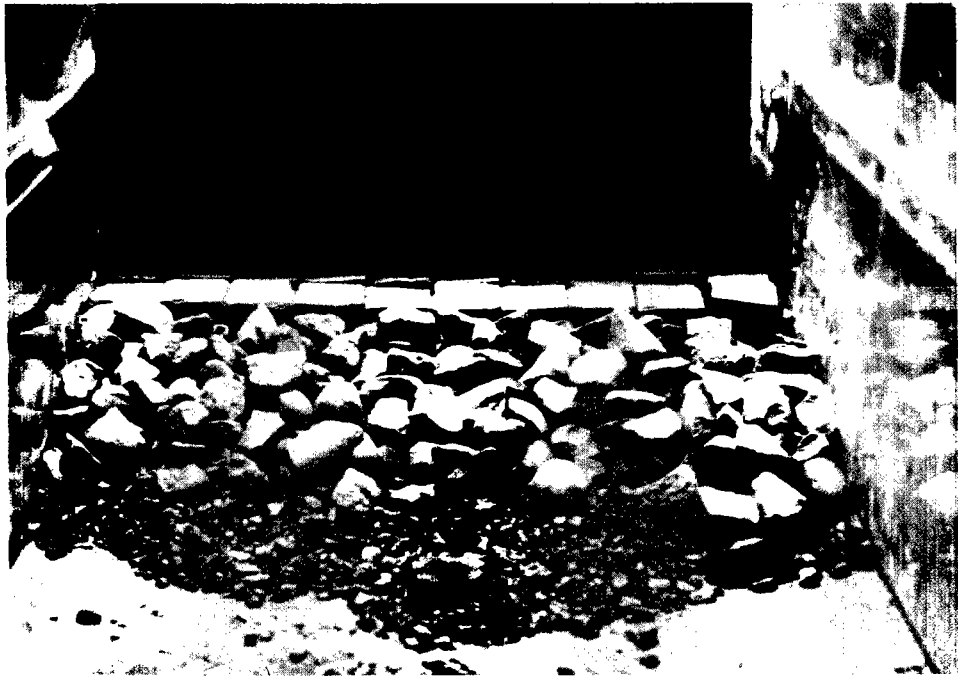
照片 11 南防波堤 0^k+450 \sim 2^k+480 断面被覆塊石滑落情形
