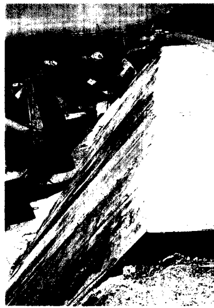
1 k +000~1 k +330段於69年~71年曾製拋40 T 及20 T 雙T型塊250個，由基礎面至胸牆頂（+10.5 m ），目前已全部流失斷裂
