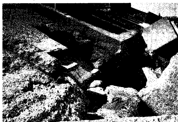
0^k+514\sim 0^k+564 段基礎災害淘空情形
