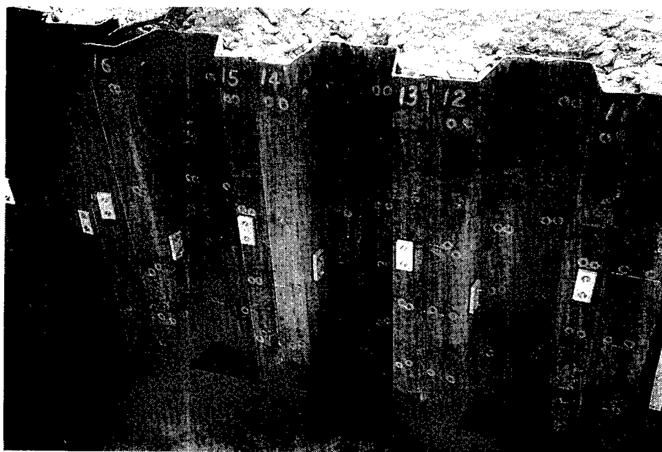
圖5 鋼板樁及陽極塊安裝之實際情形(Z形鋼板樁)
