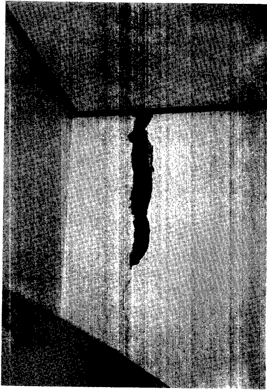
圖七、牆垂直方向破裂模式
