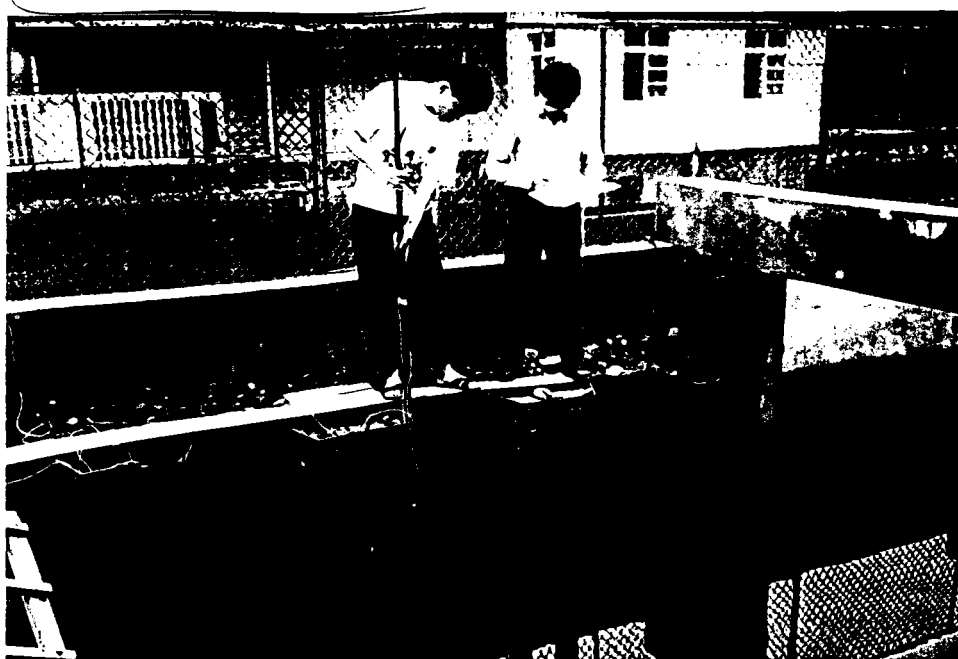
圖 2.11 定期量測鋼板樁防蝕電位之情形
