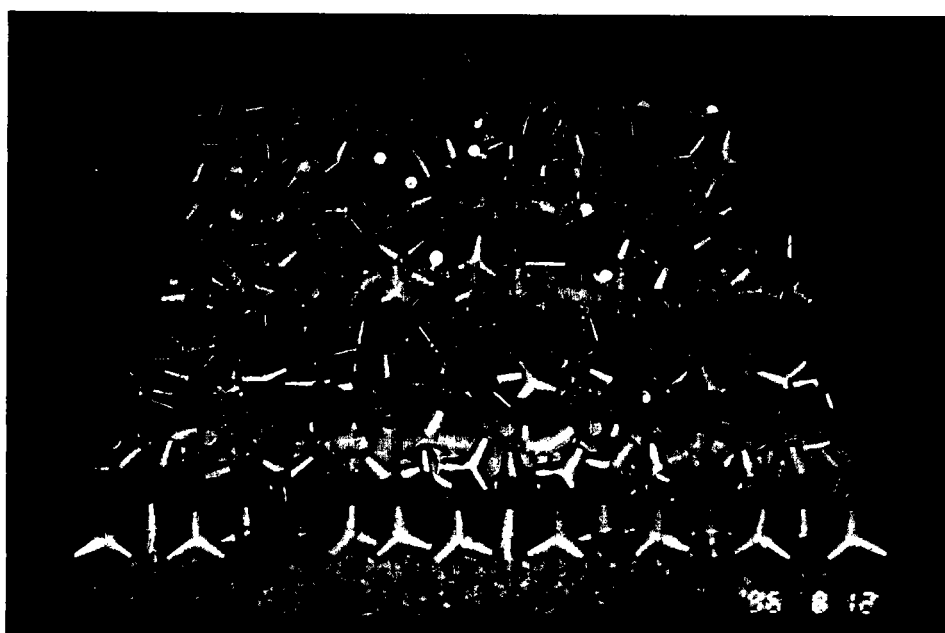
照片5 40t菱形塊排放情況
