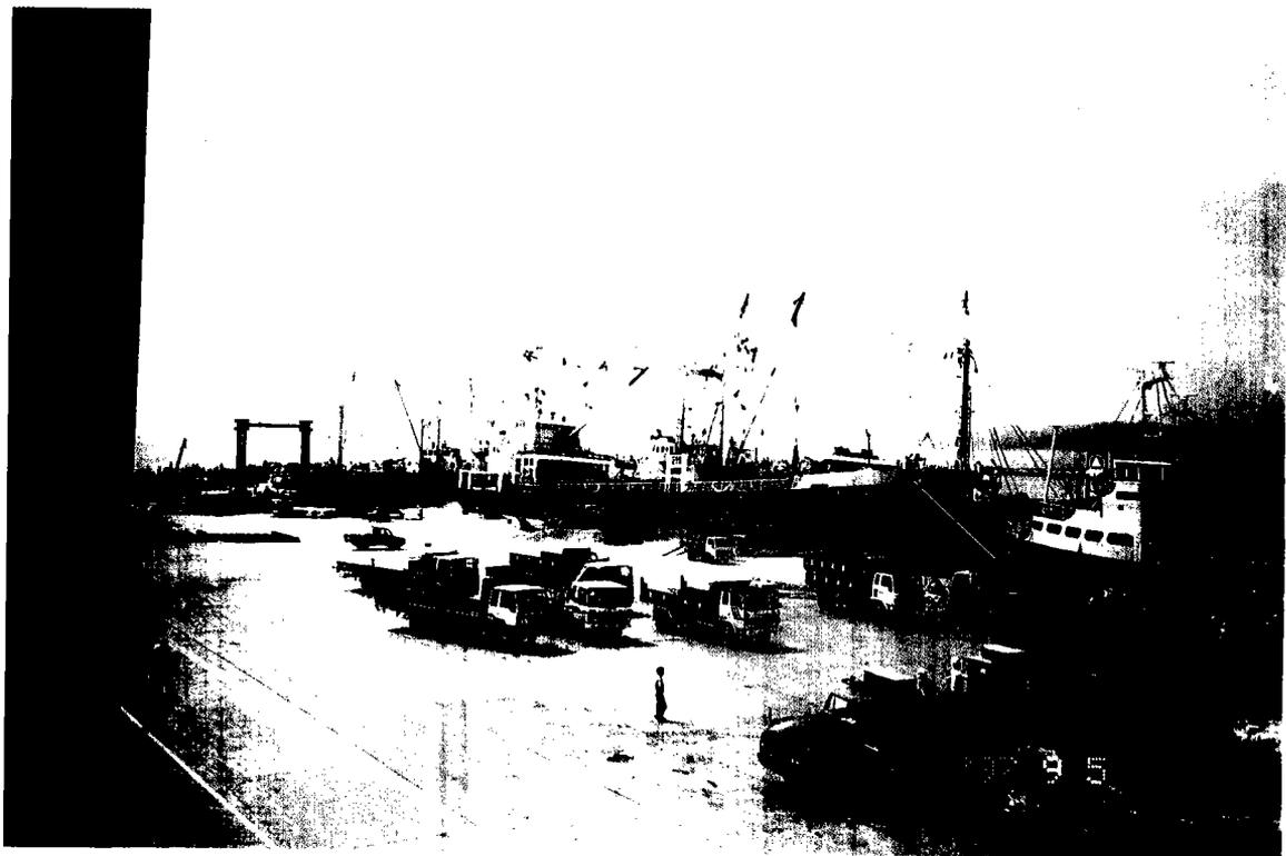
圖 6-5-2 砂石裝卸與一般貨物裝卸共用碼頭之作業情形
