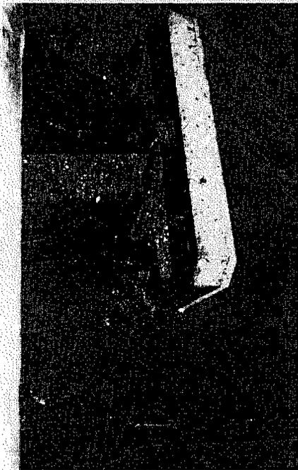
照片 4.18  $\pi$ 型大型防舷材及其破壞情形
