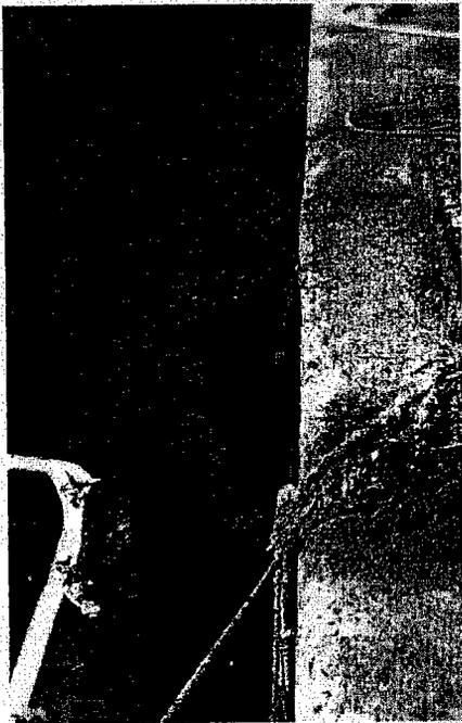
照片 4.21 老化破損的 D 型防舷材
