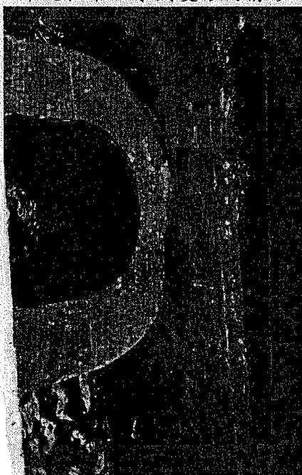
照片 4.10 D 型橡膠防舷材受船舶擠壓搓揉而造成一系列變形的情形
