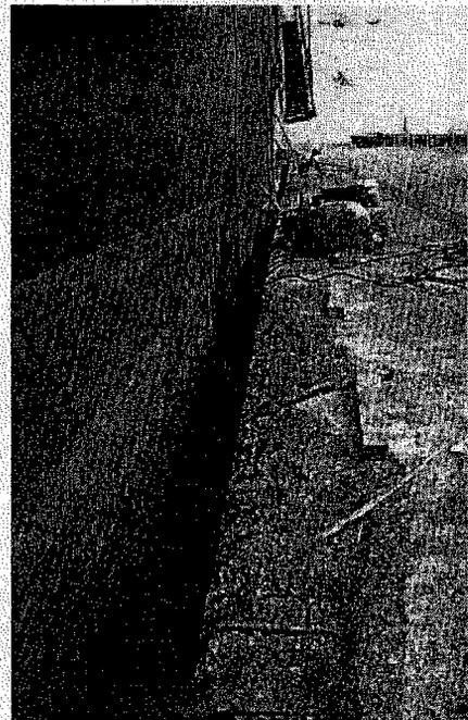
照片 4.3 碼頭混凝土崩裂，鋼筋裸露現象
