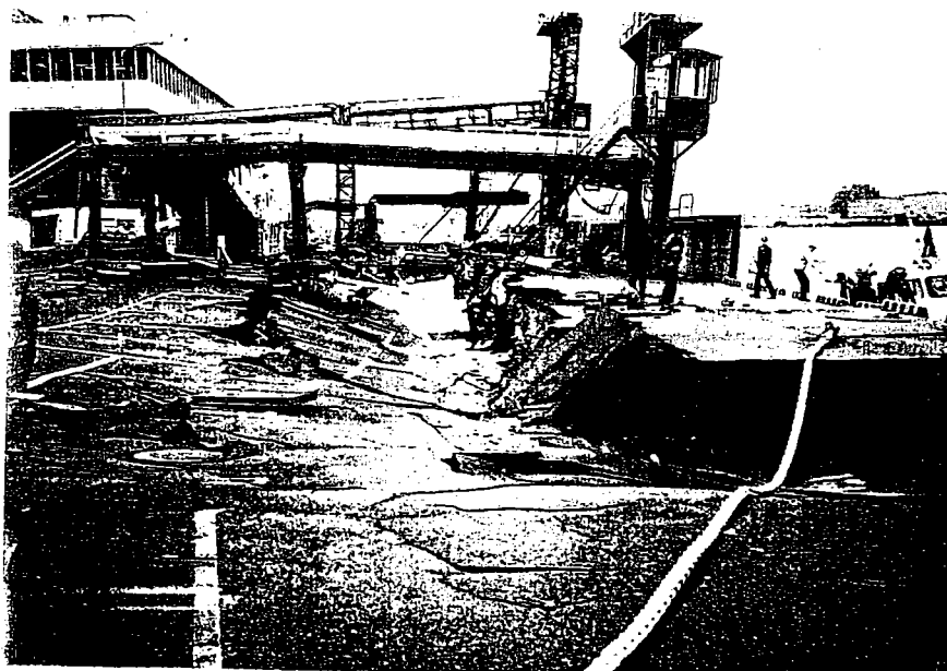
照片 6-2 1995 年日本阪神烈震，東神戸港渡船碼頭沉箱式碼頭背填土之砂液化流失，岸肩沉陷極嚴重（約 3-4m 左右）
