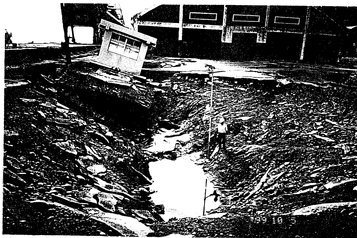
照片 6-4 台中港 2 號碼頭背填土液化後回填砂外漏 造成大坑洞深度高達 4-5 公尺
