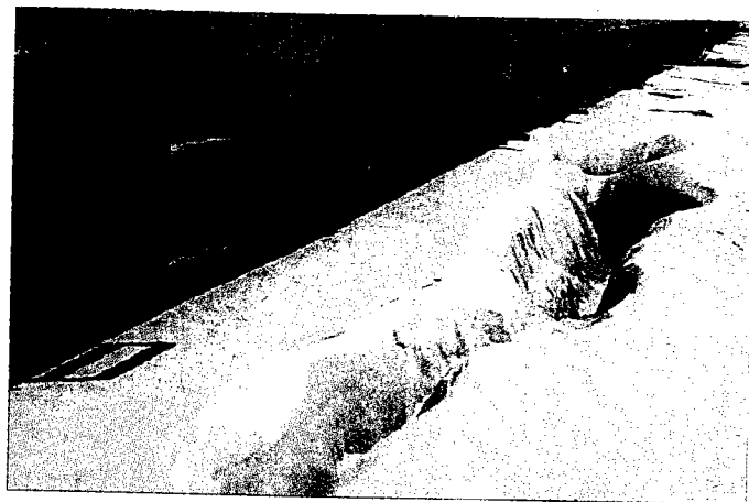
附圖A-2 台中港碼頭噴砂到處破洞
