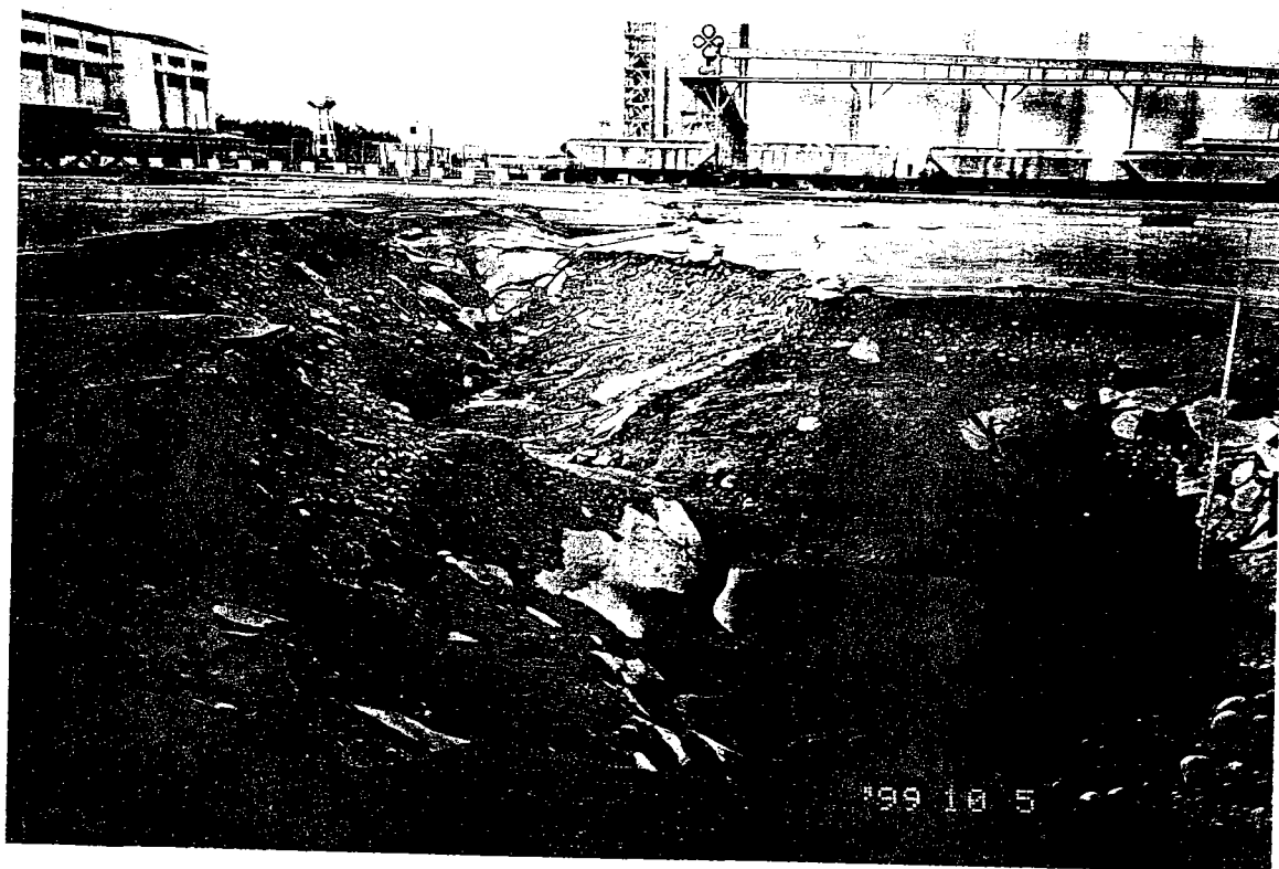
照片 6-3 台中港 1 號碼頭背填土液化後回填砂外漏 造成大坑洞深度高達 4-5 公尺
