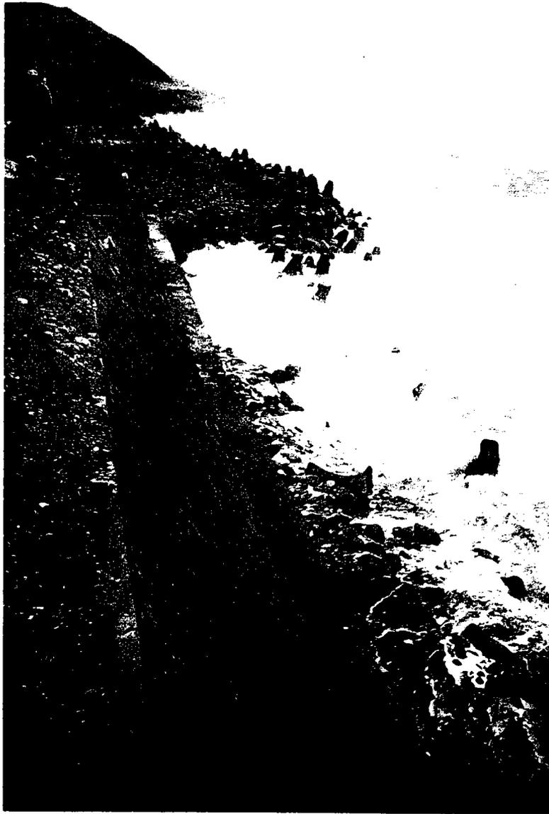
圖 20(b) 護岸基腳破壞
