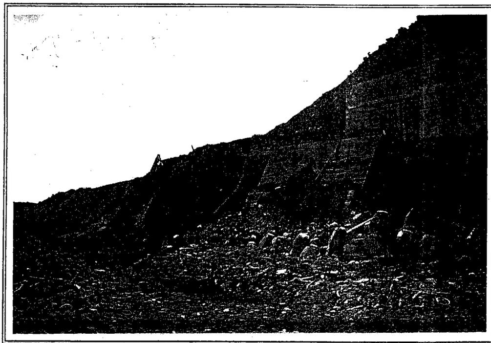
圖 17 87.10.27 芭比絲颱風 43k+580~+700 路基受損情形
