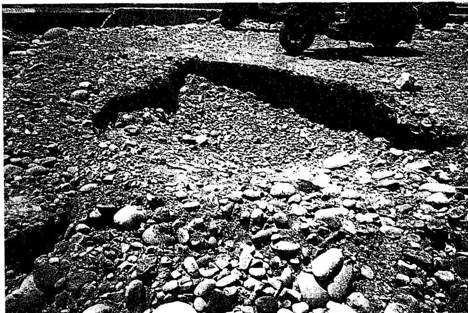
圖 26(a) 原開挖區 D 孔北側之路面凹陷
