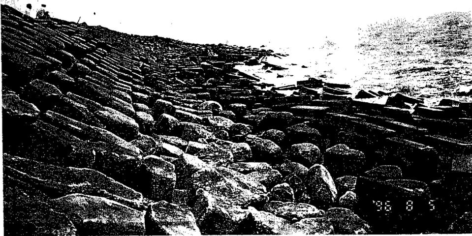
圖 28(b) 賀伯颱風造成 0K+800 堤趾流失
