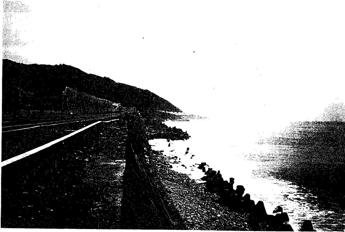
圖 20(a) 護岸基腳破壞
