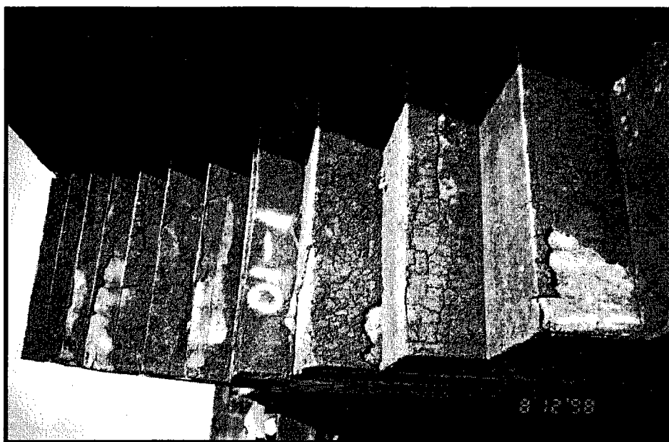
照片31 基隆港西防波堤混凝土收縮裂縫情形
