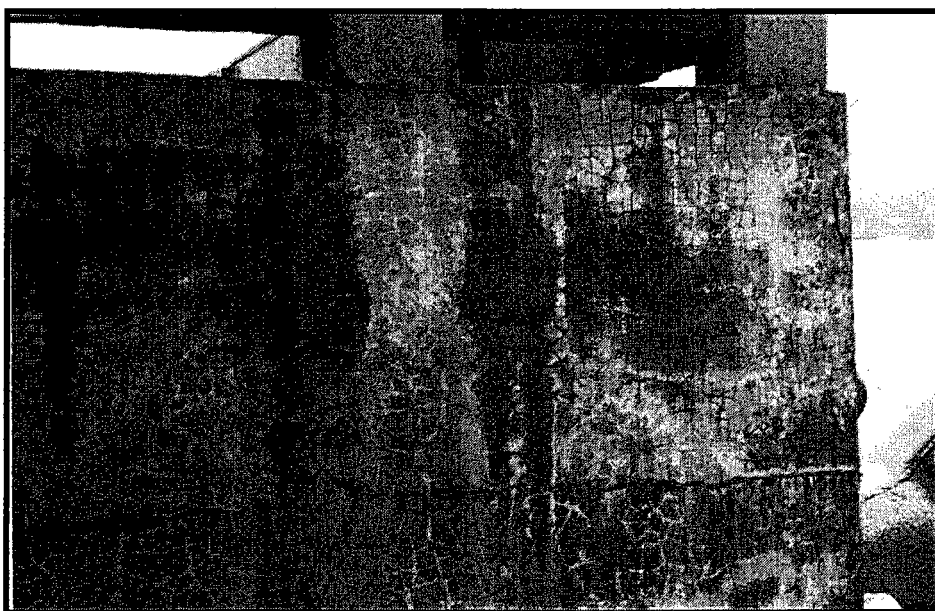
照片32 基隆港光華塔混凝土收縮裂縫情形
