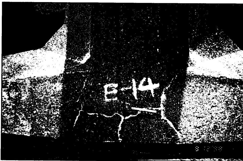
照片21 基隆港東防波堤消波塊地圖狀裂縫之十一
