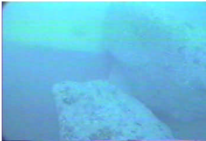
圖 34 #40 東防波堤沉箱堤腳堤址水下調查攝影
