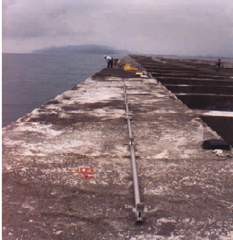
圖 3 波壓計裝設之前置作業
