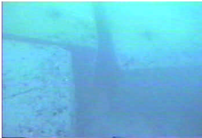
圖 40 #46 東防波堤沉箱堤腳堤址水下調查攝影
