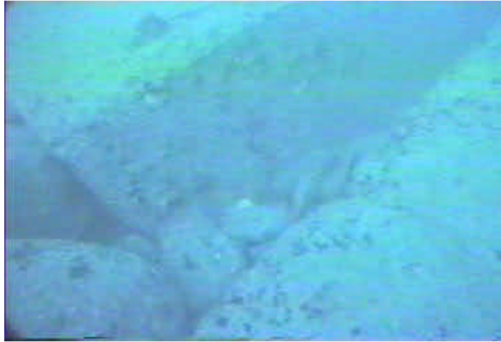
圖 41 #49 東防波堤沉箱堤腳堤址水下調查攝影
