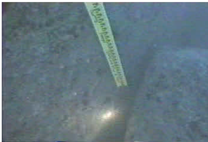
圖 29 #23 東防波堤沉箱堤腳堤址水下調查攝影
