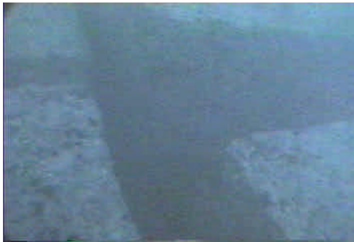
圖 28 #22 東防波堤沉箱堤腳堤址水下調查攝影
