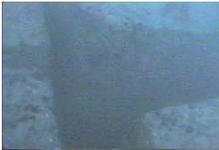
圖 32 #27 東防波堤沉箱堤腳堤址水下調查攝影
