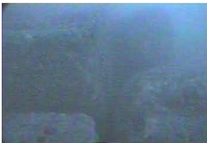
圖 30 #26 東防波堤沉箱堤腳堤址水下調查攝影
