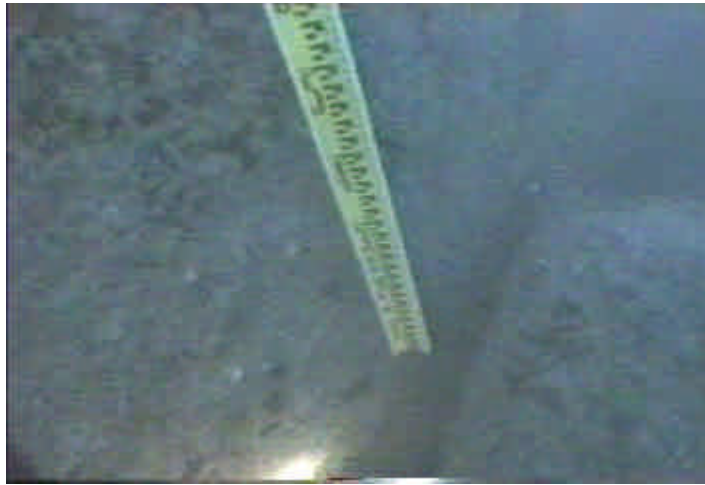
圖 31 #27 東防波堤沉箱堤腳堤址水下調查攝影
