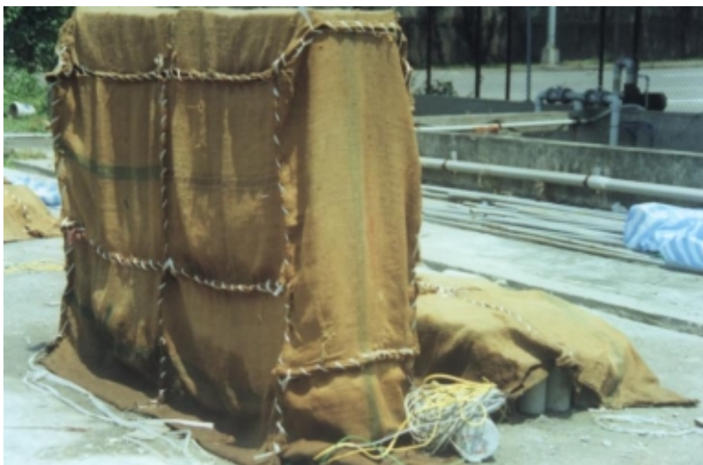
照片 3.4 試驗牆及圓柱試體以濕麻布濕治養護
