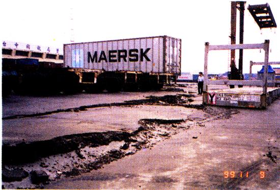
照片 1-11 921 地震台中港 9-11 號碼頭後線之土壤液化，地表發生崩裂及差異沉陷
