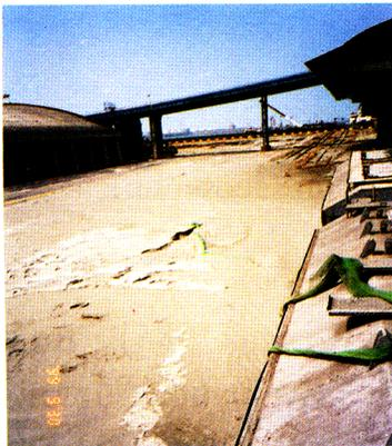
照片 1-3 台中港 1 號碼頭後線鐵軌之土壤液化，地表留下約長 80m、寬 20m、厚 15cm 之噴砂
