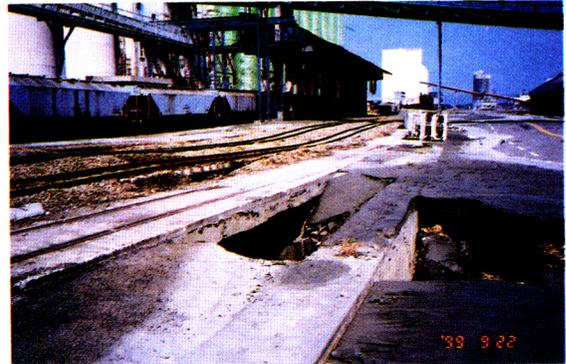
照片 1-2 台中港 1 號碼頭後線排水溝附近之土壤液化，地表並留下約 15cm 厚之噴砂
