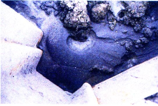
照片 1-9 1022 嘉義地震嘉義市忠義橋下，液化砂土沿版樁與土壤界面噴出而形成之噴砂孔(倪勝伙教授提供)
