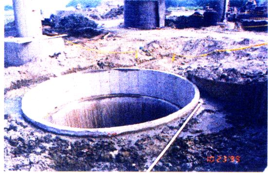
照片 1-10 1022 嘉義地震嘉義市忠義橋下之沈箱因液化而向河中傾斜(相片中之左下角方向)(倪勝伙教授提供)
