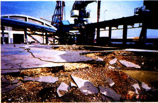
照片 1-1 台中港 1 號碼頭後線背填土之砂液化流失，造成約 4-5m 深之大坑洞，地表並留下約 10cm 厚之噴砂
