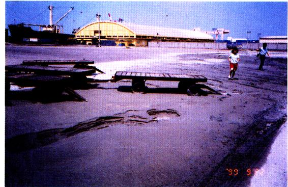
照片 1-12 921 地震台中港 13 號碼頭後線排水溝附近之土壤液化，地表並留下約長 30m、寬 5m、厚 10cm 之噴砂
