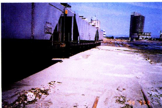
照片 1-7 台中港 3 號碼頭後線鐵軌附近之土壤液化，留下約長 50m、寬 20m、厚 15cm 之噴砂
