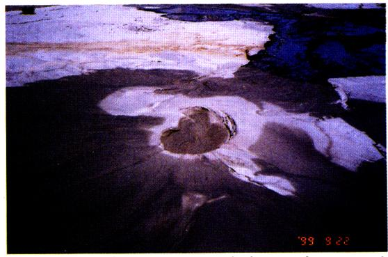
照片 1-6 台中港 3 號碼頭後線之土壤液化，地表留下之圓形噴砂孔
