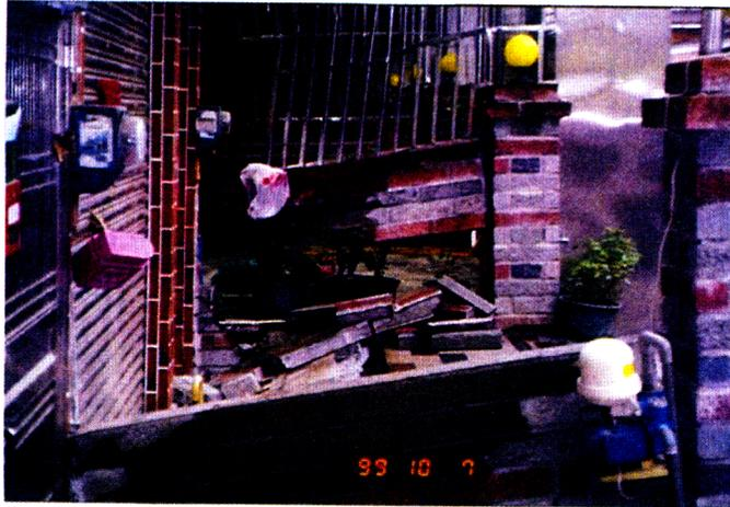
照片 4.4 沉陷引致之結構物破壞
