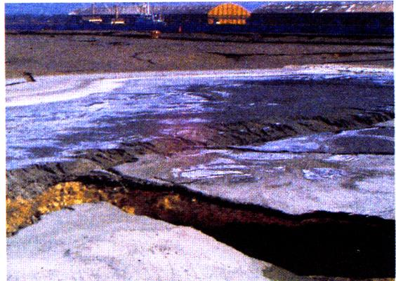
照片 1-4 台中港 2 號碼頭後線之土壤液化，地表留下之長條形噴砂孔
