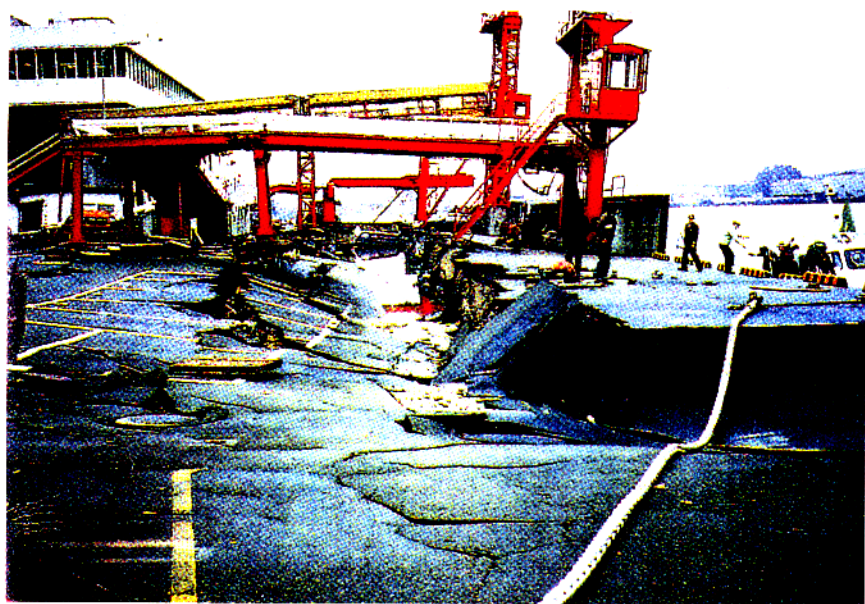
照片 1-2 1995年日本阪神烈震，東神戸港渡船碼頭沉箱式碼頭背填土之砂液化流失，岸肩沉陷極嚴重(約3-4m左右)
