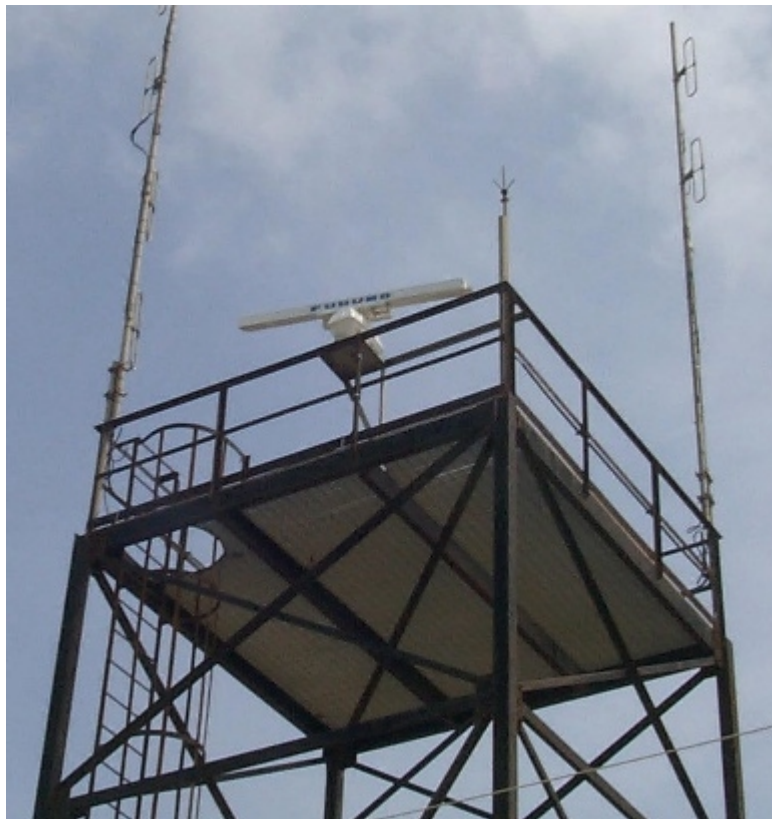
圖 9-1、雷達測波儀天線裝設在台北港分局港航課辦公室後方之無線電接收鐵塔上。
