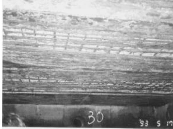
圖 11 碼頭 R.C.面版，底面混凝土剝落、鋼筋外露及嚴重腐蝕之情形
