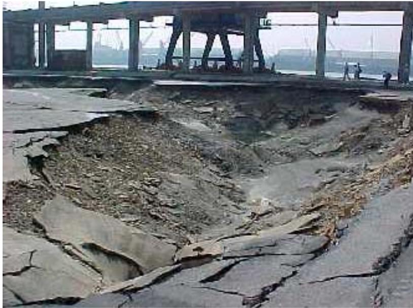
圖 1.1-4 集集地震台中港之破壞
