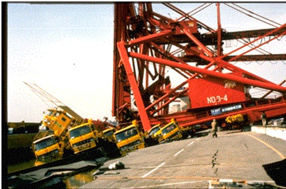
圖 1.1-1 神戶地震沉箱側移引起設備破壞
