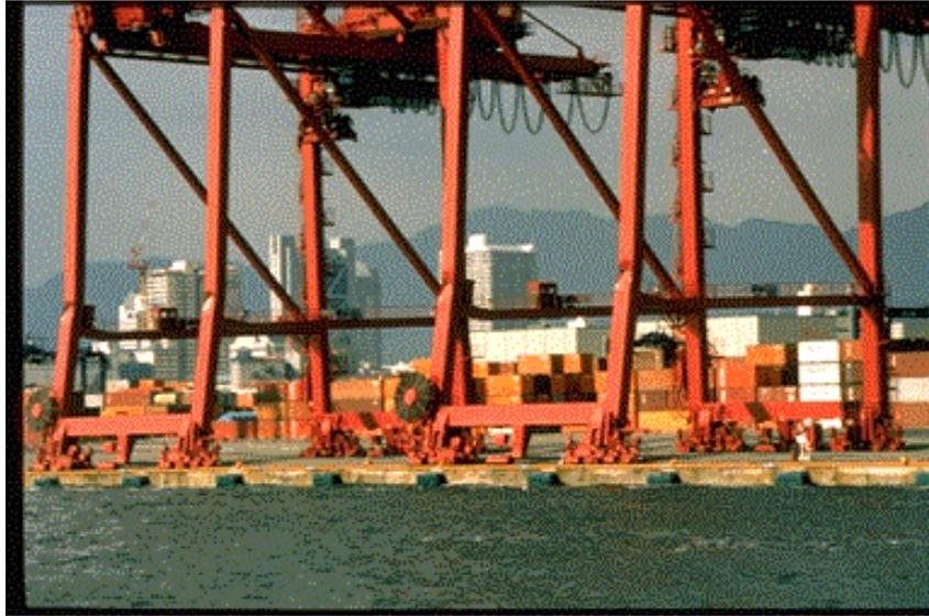
圖 1.1-2 神戶地震沉箱側移引起起重機柱腳降伏彎曲
