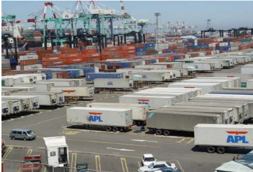
圖 3.1.1 車架作業法
