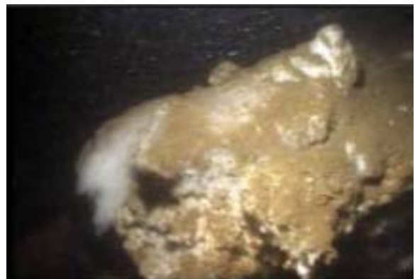
圖 3.38 海床底部陽極塊表面淤泥
