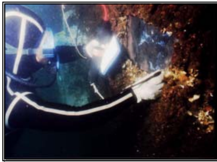
圖 3.3 水面下超音波量測鋼板
