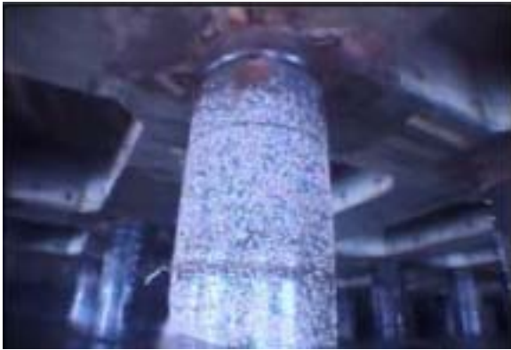
圖 3.34 海水面上鋼管樁表面
