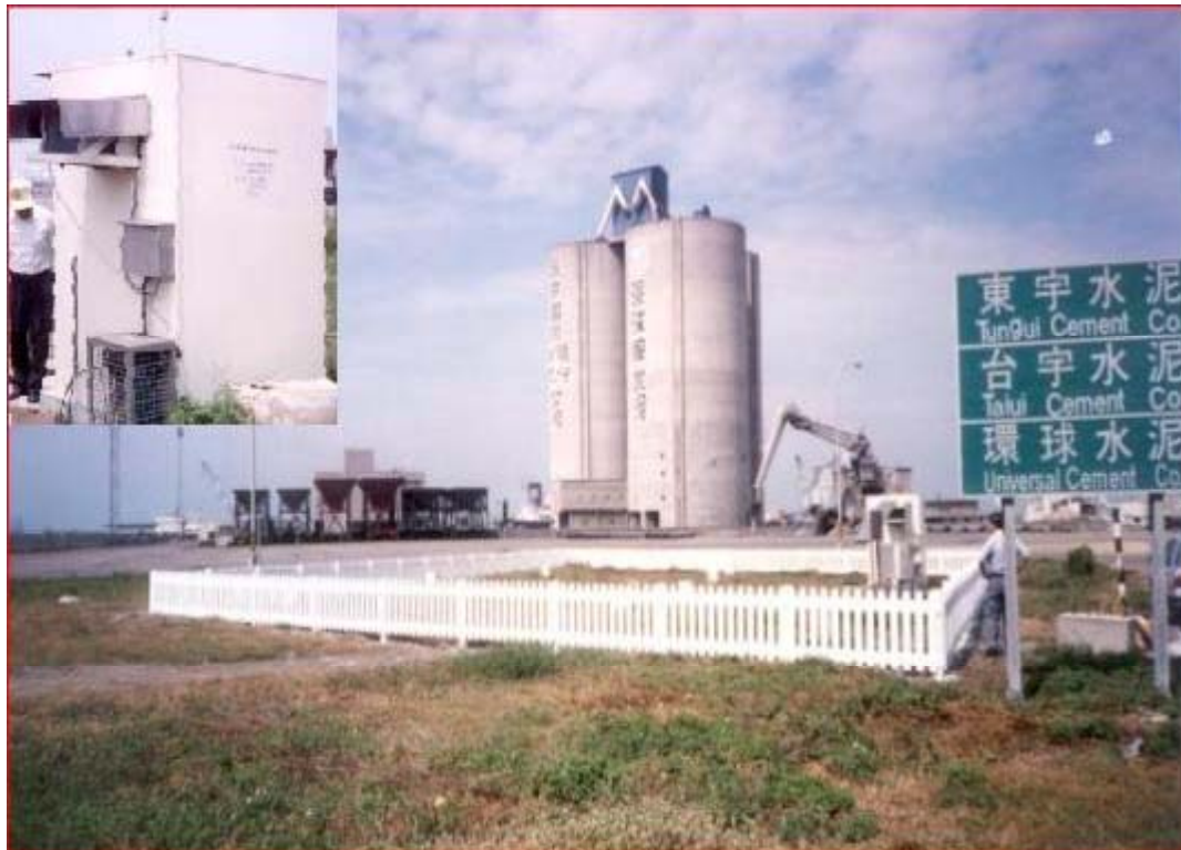
圖 16-9 台中港區地震分層監測站設置完成外貌狀況
