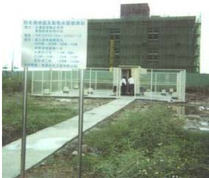
圖 2-13 台北港區地震分層監測站設置完成外貌狀況
