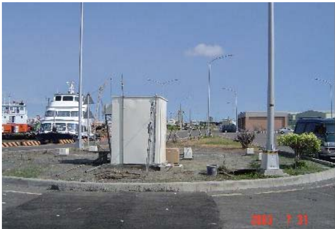
圖 2-15 高雄區地震分層監測站設置完成外貌狀況
