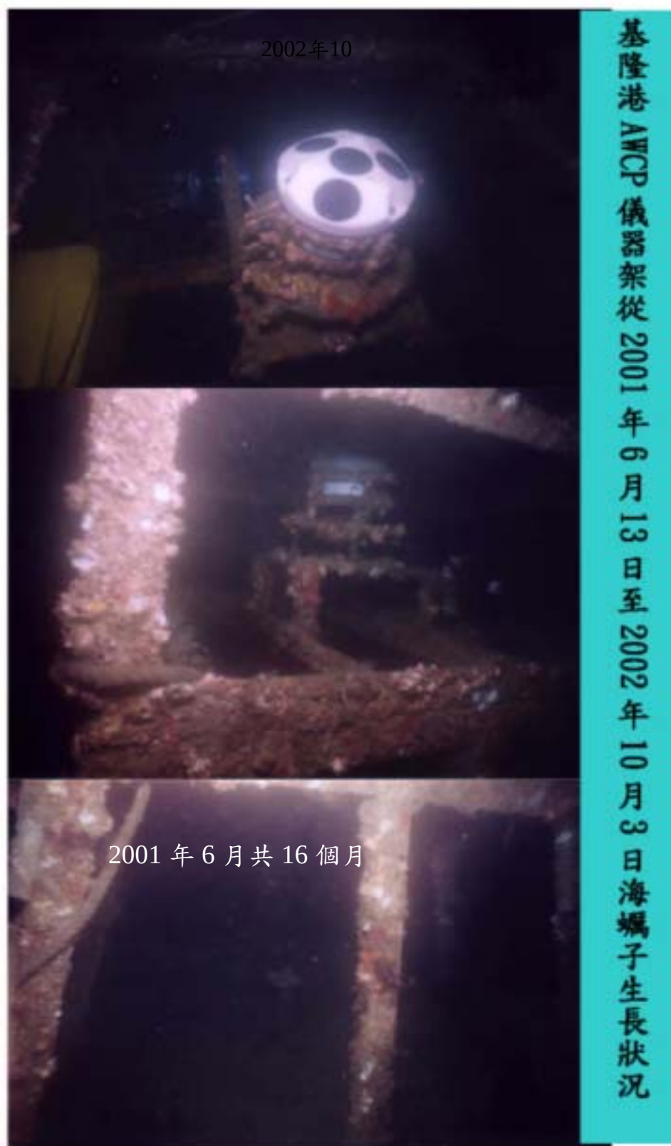
圖 2.14 AWCP 監系統水下安裝後之狀況圖(3)
