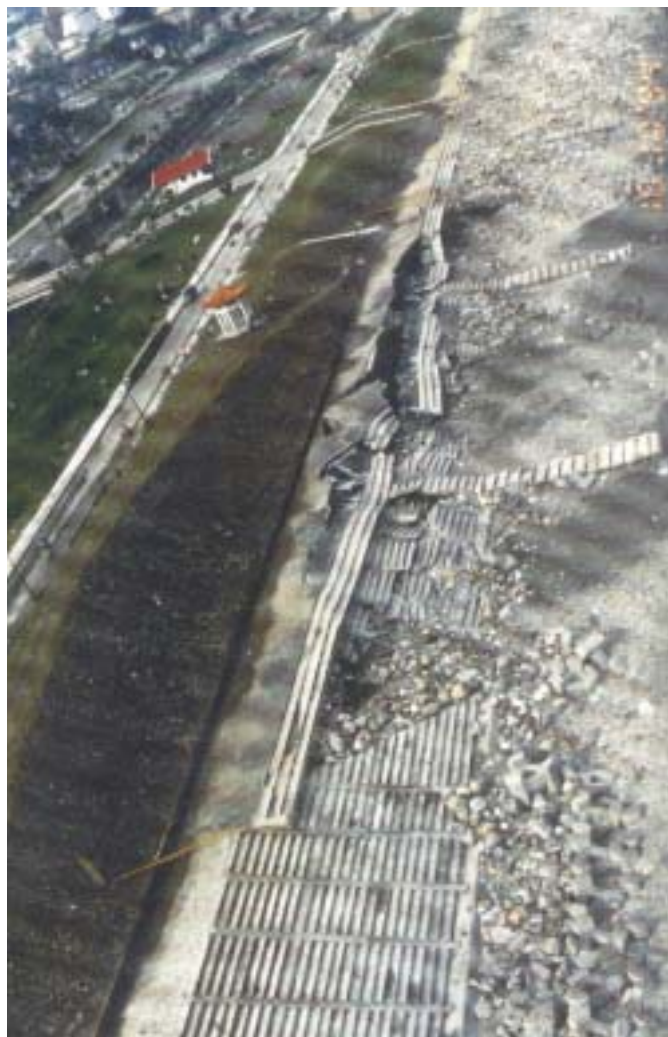
照片 2.25 花蓮南濱親水性堤岸受颱風波浪破壞情形
