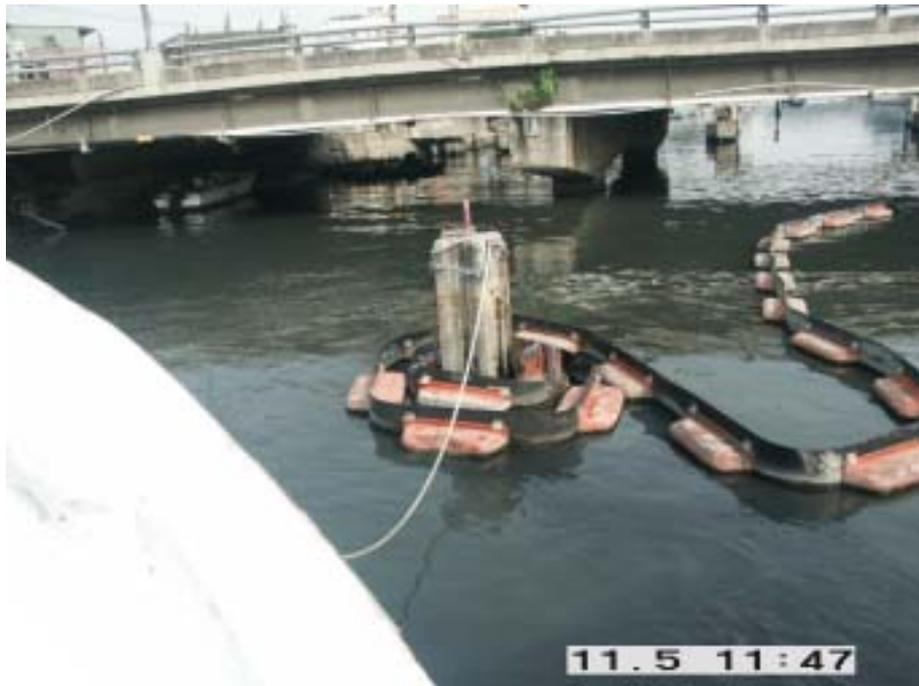
照片 3.3 前鎮河河口安裝儀器進行現場觀測作業用之水泥柱
