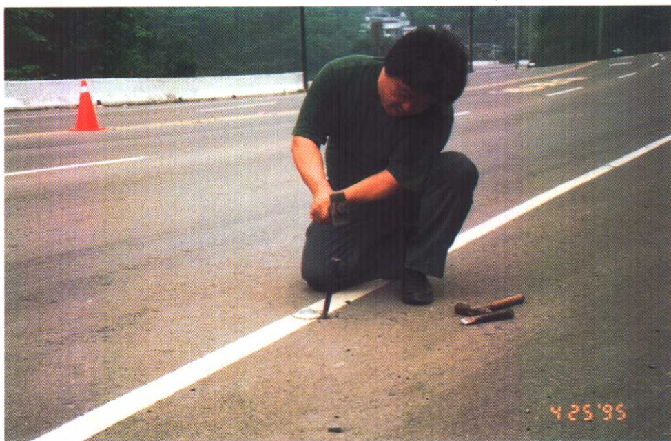
照片 3 挖取強化玻璃反光標記一景(地點：新竹縣台 3 線)
