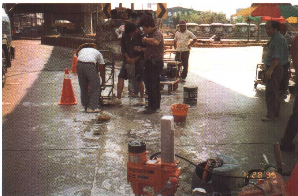
照片 11 新品埋設試驗鑽孔作業(中山高速公路高雄端出口)
