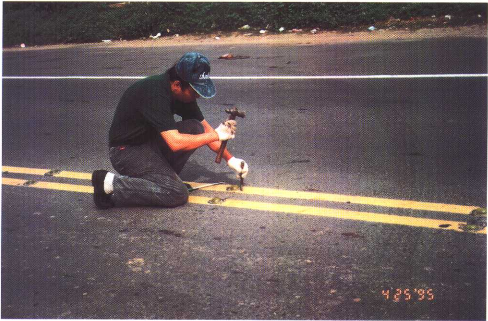
照片 1 挖取強化玻璃反光標記一景(地點：新竹市忠孝路)
