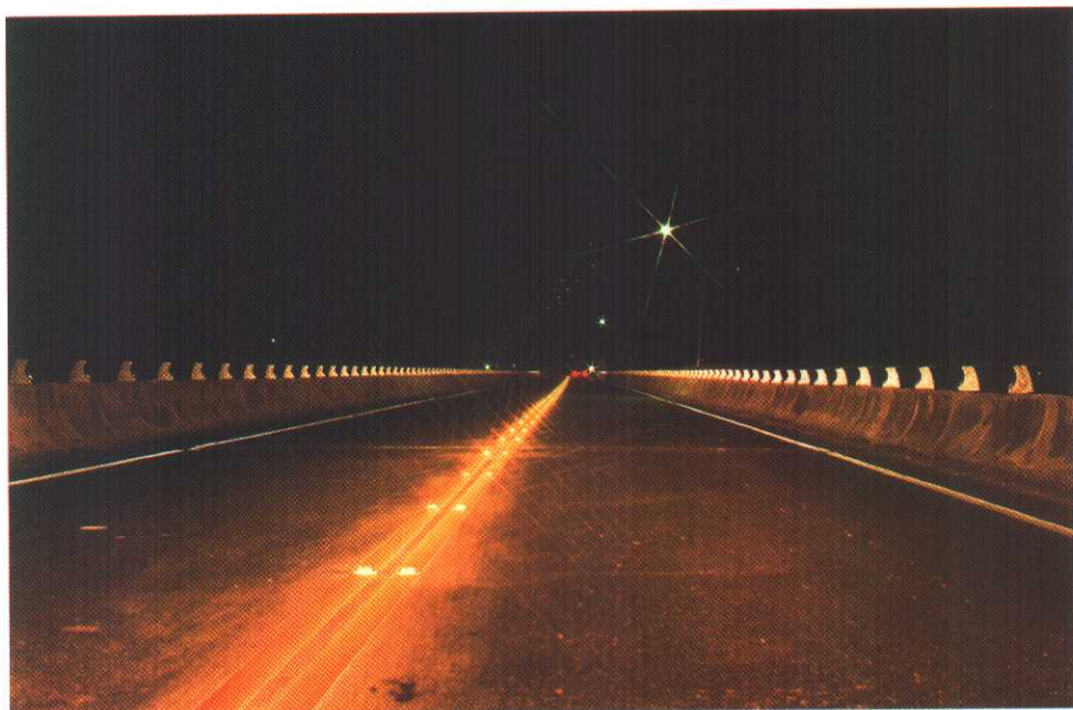
照片 17 強化玻璃反光標記夜間反光效果一
