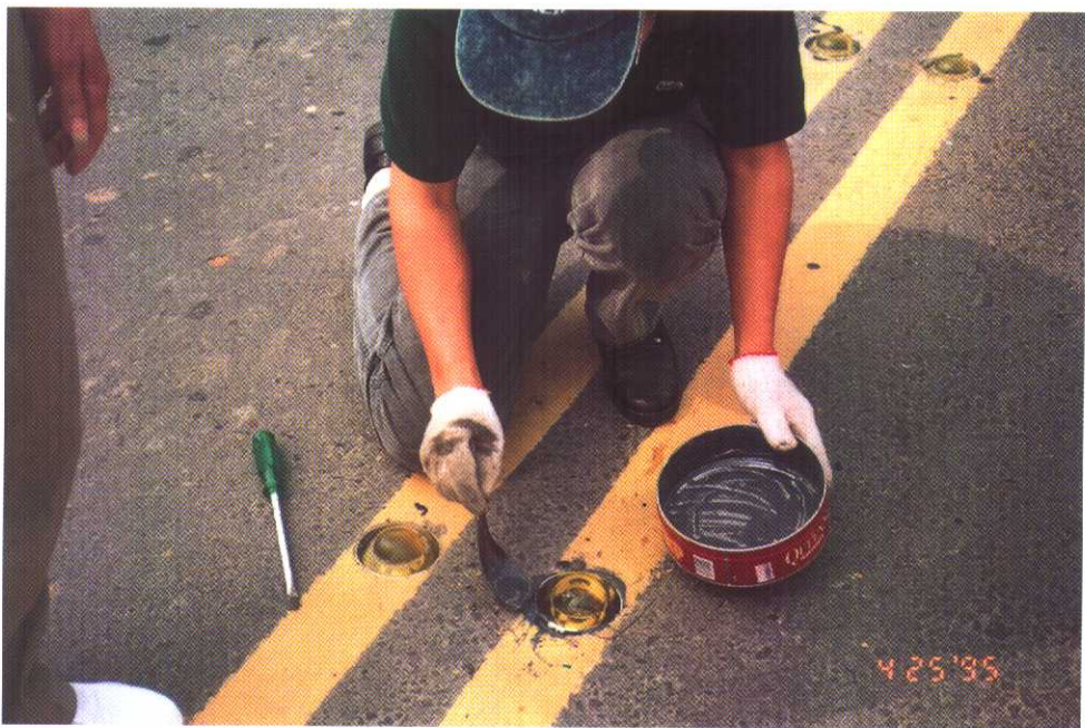
照片 2 挖取路面標記後回填一景(地點：新竹市忠孝路)
