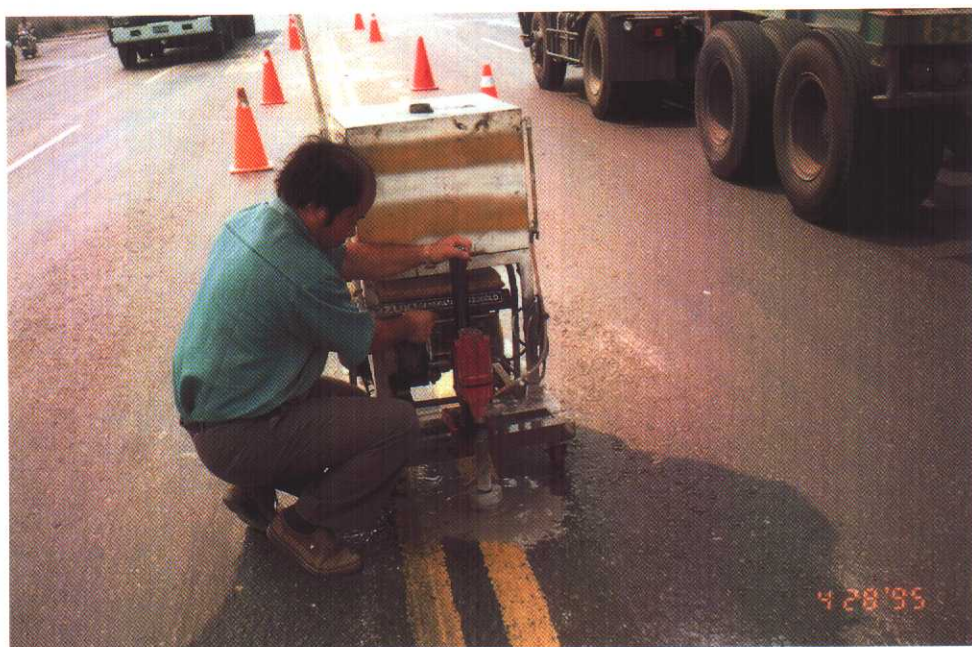
照片 5 360°標記安裝過程：鑽孔(地點：高雄市新生路)
