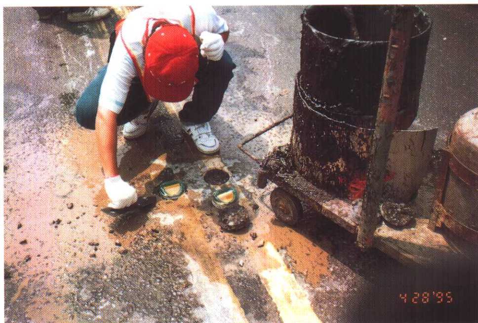
照片 6 倒入瀝青膠後置入 MK6 型標記(地點：高雄市新生路)
