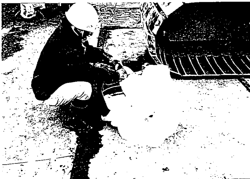
照片8-1 裝設網袋準備吊入套管 (攝於東京羽田機場地盤改良工程)
