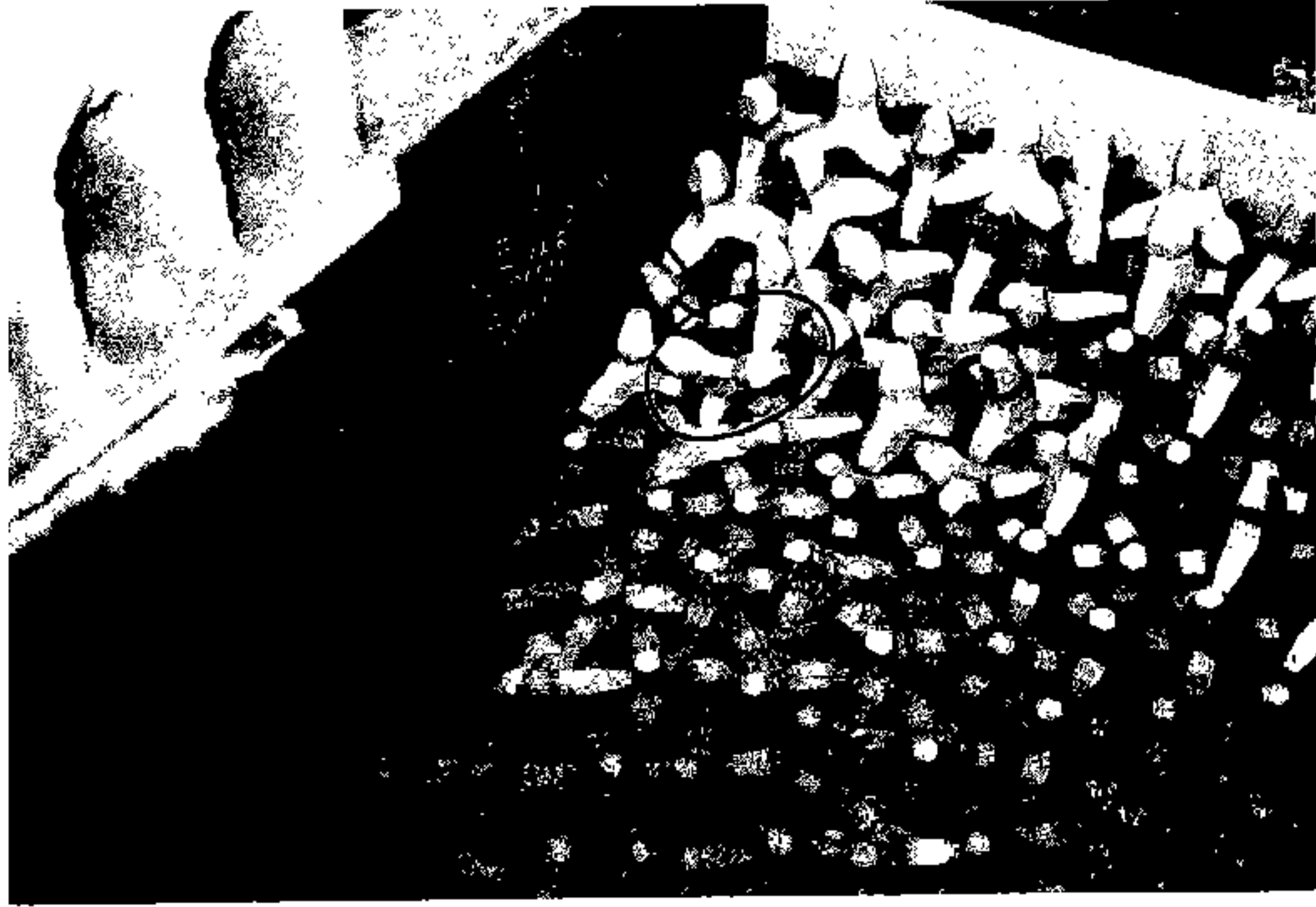
照片4-3-3C 協克塊發生晃動破壞的情形
