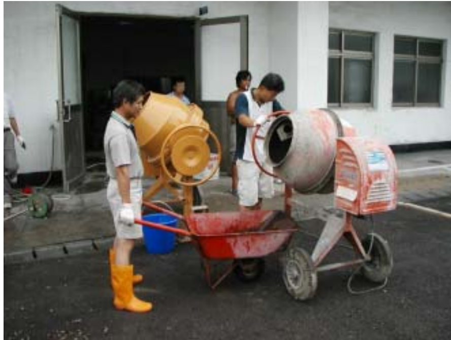
照片 4.1 混凝土拌合機拌合情形
