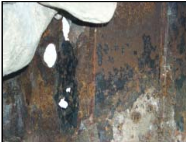
圖3.27 花蓮港5號碼頭鋼板樁 陸側破洞（2）
