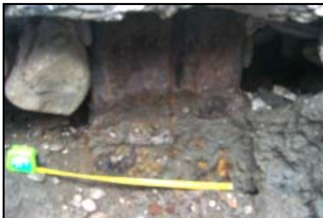
圖3.25 花蓮港5號碼頭鋼板樁 陸側生銹情形
