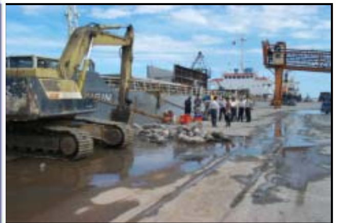
圖3.23 花蓮港5號碼頭鋼板樁陸側開挖現場之情形
