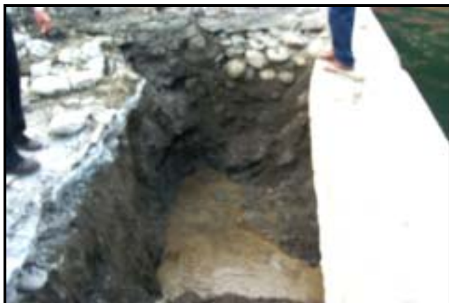
圖3.24 花蓮港5號碼頭鋼板樁 陸側開挖後情形
