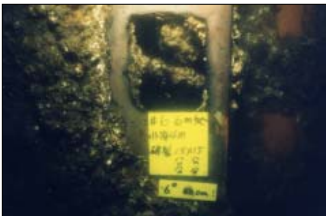
圖3.35 花蓮港6號碼頭鋼板樁6 m處開孔之情形
