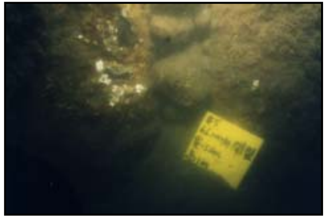
圖3.21 花蓮港5號碼頭鋼板樁海床處開裂之情形
