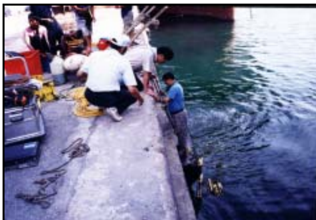
圖3.29 花蓮港鋼板樁陸側檢測情形 （超音波法）
