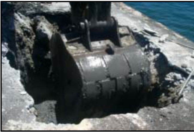
圖3.41 花蓮港航道岸壁鋼板樁陸側開挖情形
