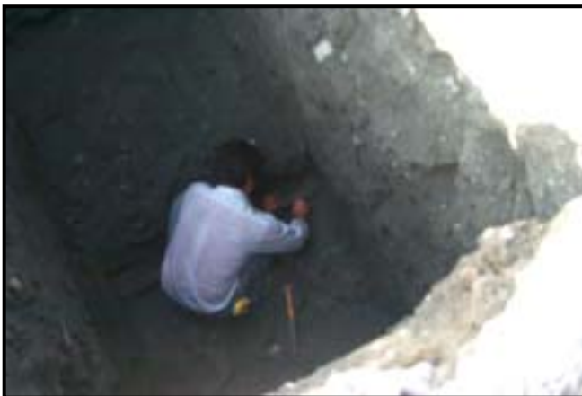
圖3.43 花蓮港航道岸壁後方10 m處開挖後情形
