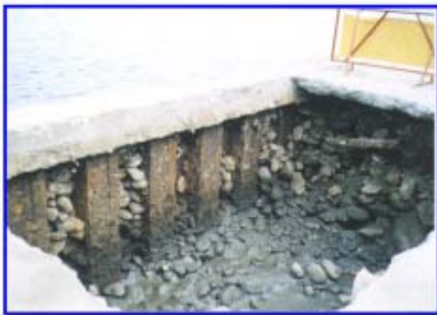
圖3.22 花蓮港4號碼頭鋼板樁陸側破洞之情形
