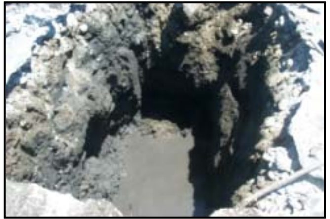
圖3.42 花蓮港航道岸壁開挖後背填土情形
