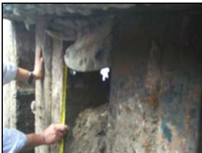
圖3.26 花蓮港5號碼頭鋼板樁 陸側破洞（1）
