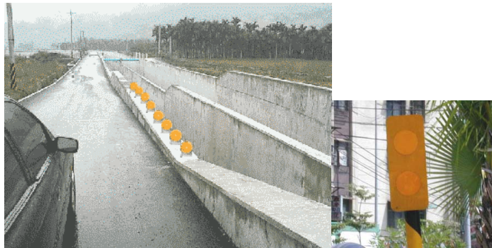
圖 7.1-9 護欄導標設置範例
