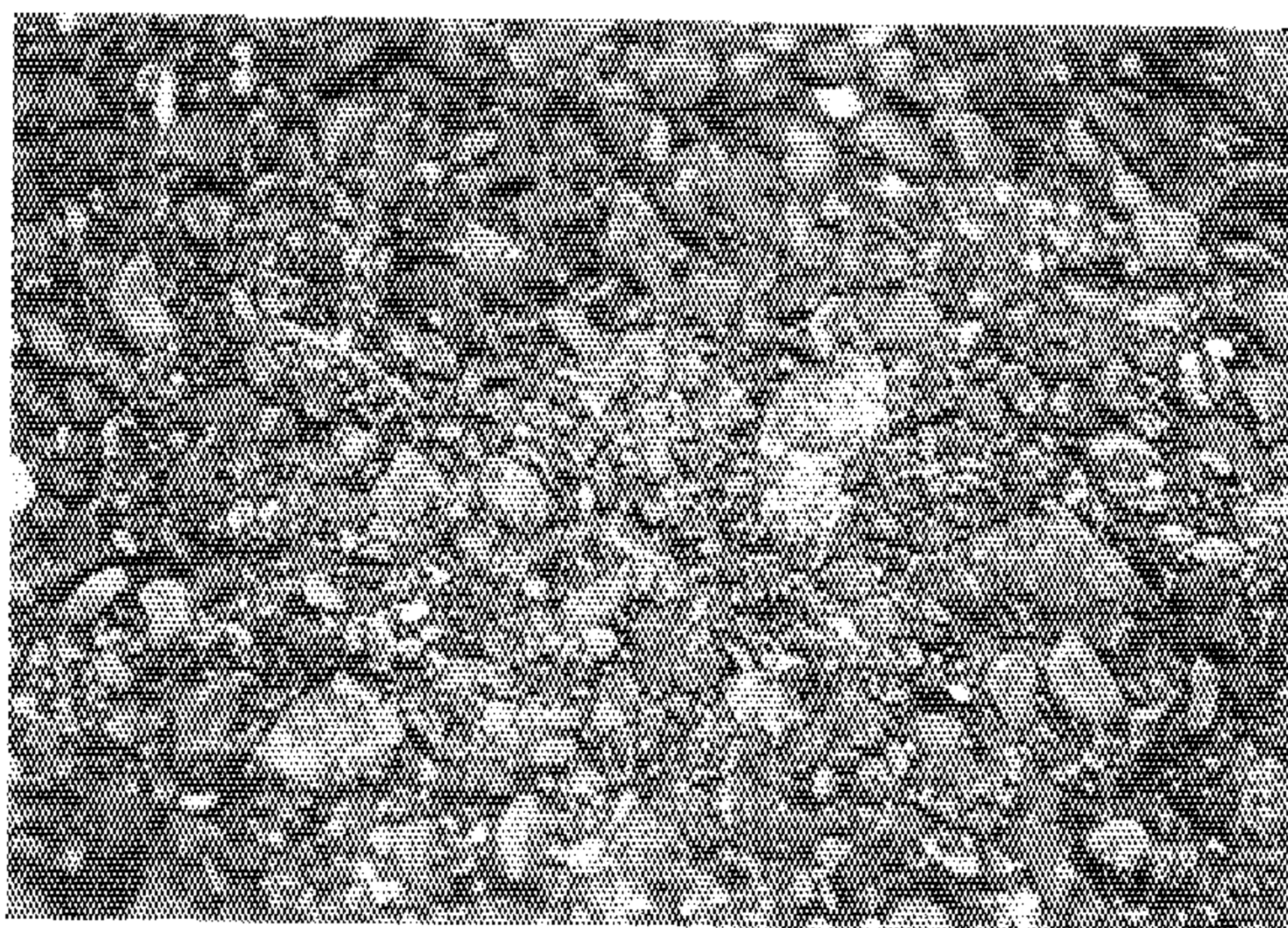
圖28. 南投路面煞車時石子有脫落現象 1-2。
